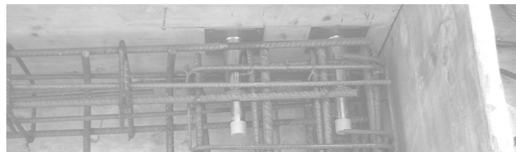
TIPOLOGÍA JUNTA ESTRUCTURAL SISTEMA GOUJON CRET
