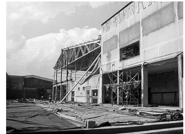
Ilustraciones 116 y 117 – Foto de la maqueta y de la obra. (Fuente: Gui Paoliello)
