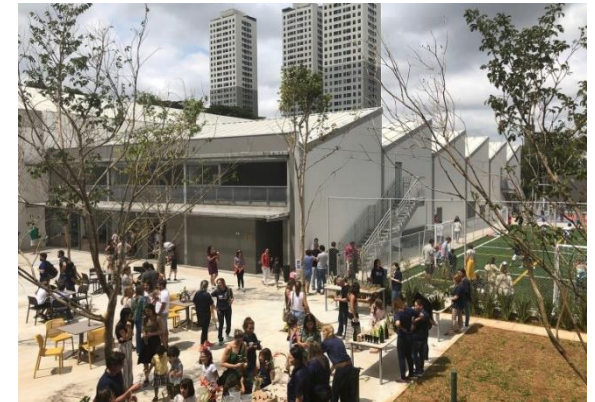
Ilustración 64 - Exterior de la Nave B reciclada (Fuente: https://techne.pini.com.br/tag/beacon/ )
