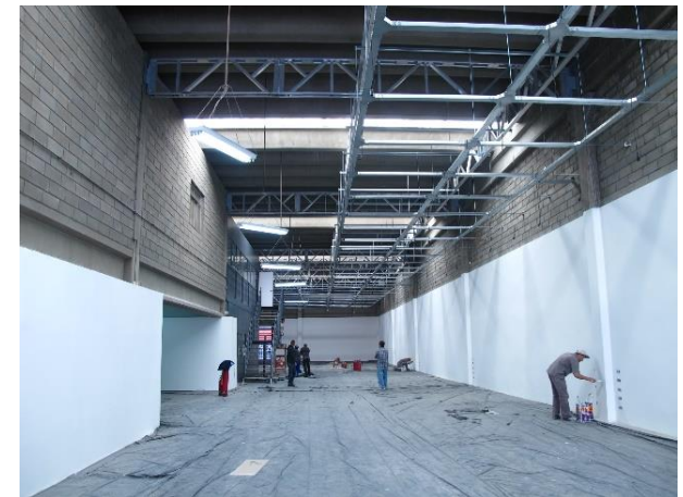
Ilustraciones 102 y 103 – El interior de la nave antes del reciclaje y durante la obra. (Fuente: Gui Paoliello)
