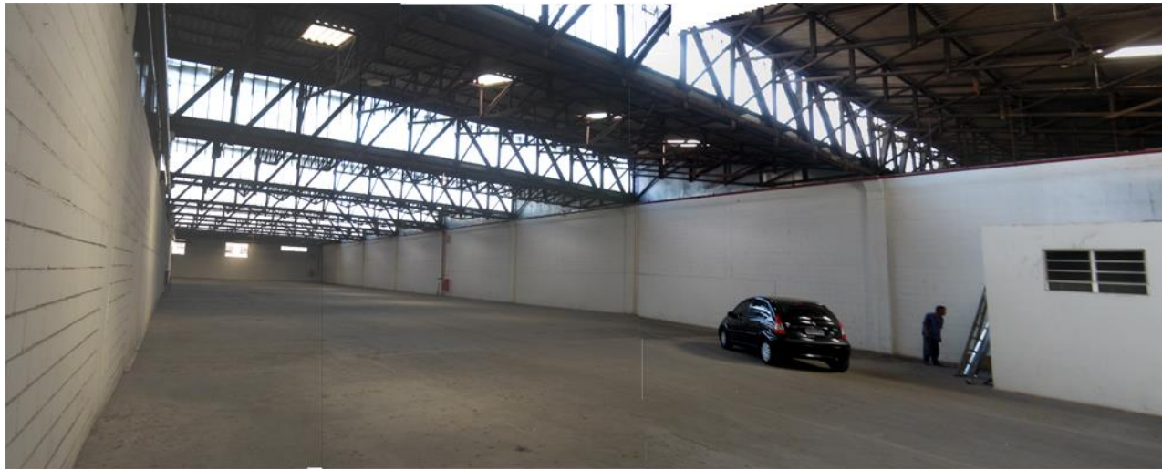
Ilustración 130 – Interior de la nave antes del reciclaje (Fuente: Pietro Terlize)
