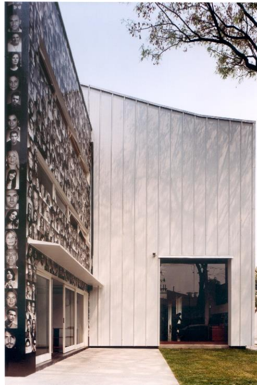
Ilustraciones 123 a 126 – Fachadas de las naves recicladas y el interior de la nave existente reprogramada en un espacio de oficina. (Fotografía: Nelson Kon)
