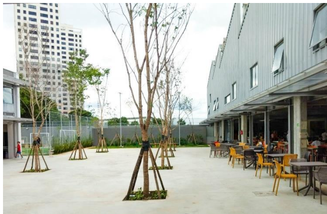
Ilustración 71 - Interior de la Nave C después del reciclaje (Fuente: Andrade Morettin Arquitectos)
