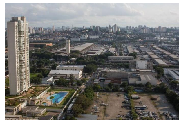
Ilustración 38 – Edificación residencial de obra nueva cercana al Ceagesp. (Fuente: El país. “Casa popular em áreas nobres, nao!” https://brasil.elpais.com/brasil/2015/04/02/politica/1427938647_756022.html .)
