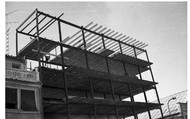
Fig. 5.28: Primer edificio de Caravaca que se construyó con estructura metálica. Ocupa el solar donde se ubicaba el Cine de verano.
