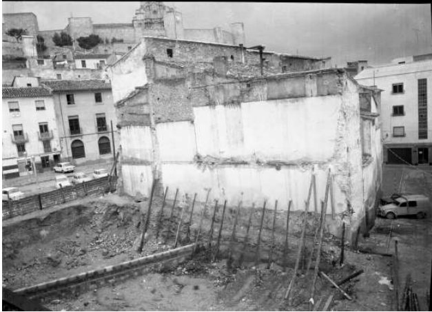
Fig. 6.6: Derribo de la casa de la familia Sahajosa, en la plaza del Arco. Además de este, muchos edificios patrimoniales se perdieron entre los 60 y 80.
