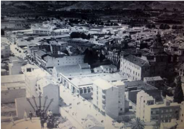
Fig. 5.11: Mercado de Abastos tras su reforma y ampliación. La Gran Vía está cada vez más consolidada.
