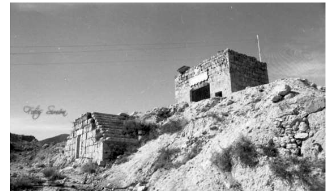
Fig. 4.12: Ermita de la Reja, estación final del Vía Crucis en la cima del cerro del Calvario.
