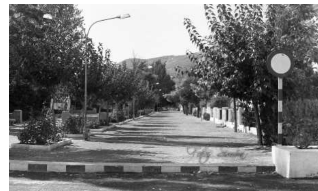
Fig. 5.13: Aspecto del Camino del Huerto tras su acondicionamiento.
