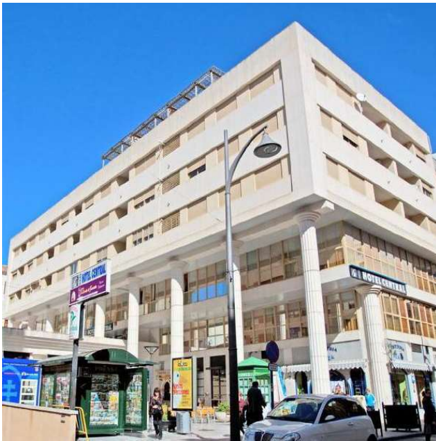
Fig. 6.9: Edificio que se construyó sobre la Plaza de Abastos.
