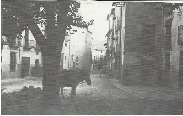
Fig. 4.6: Plaza Nueva o del Progreso.
