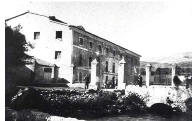
Fig. 4.18: Fábrica de las Fuentes del Marqués. Inicialmente sólo de harinas, después también de luz, y acualmente de hielo.
