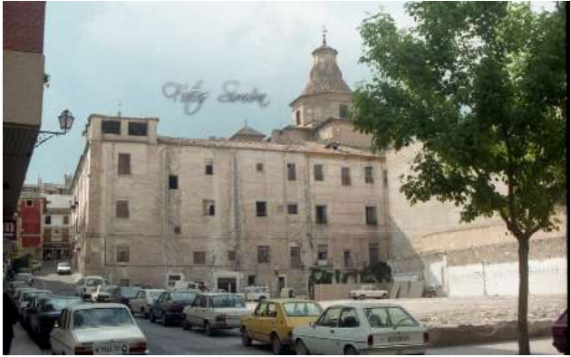
Fig. 6.8: Solar que dejó la Plaza de Abastos tras su derribo.
