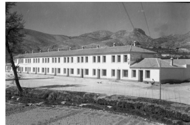
Fig. 5.12: Grupo de viviendas de protección oficial Santa Cruz, en el Camino del Huerto.
