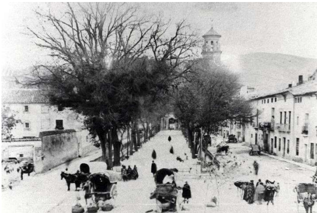
Fig. 3.12: El paseo de la Glorieta, con el Templete al fondo.
