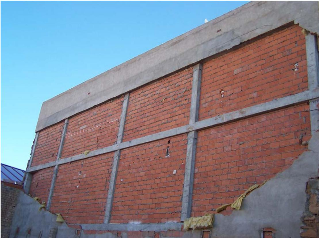
Foto 1: Derrumbe de hoja exterior de cerramiento cerámico.
