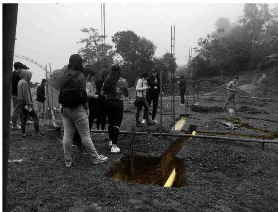
Figura 70: Nuevo proceso de cimentación para viviendas Nasa, en la que se incluyen zapatas, tuberías y estructuras de hierro, con ayuda de estudiantes de Arquitectura
