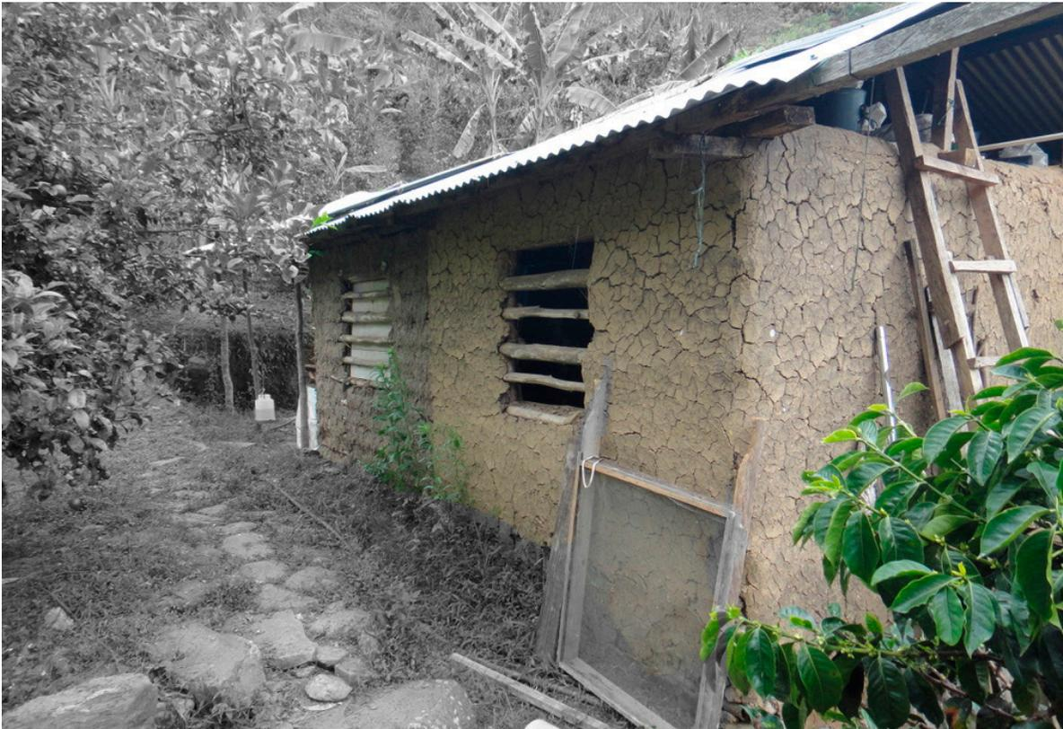
Figura 73: vivienda actual nasa, en la que se conservan tradiciones como muros de barro, dos vanos en la fachada y el Tul en la parte trasera.
