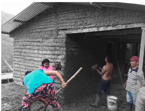
Figura 30: Proceso de autoconstrucción de una vivienda Nasa
