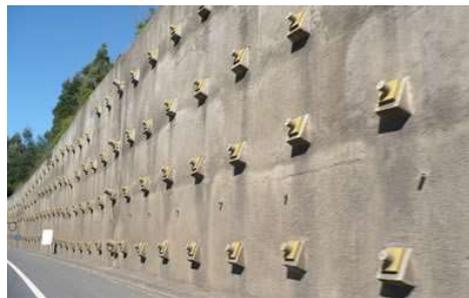
Figura 90: Anclajes activos en talud de carretera, fuente Nacional de Perforaciones SAS
