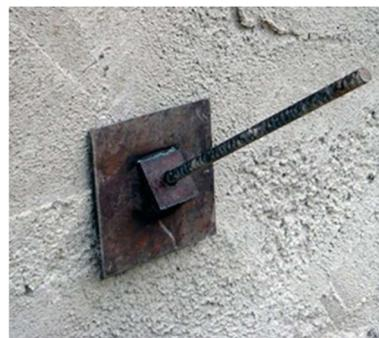
Figura 91: Anclaje pasivo formado por un bulón, fuente block de Víctor Yepes.
