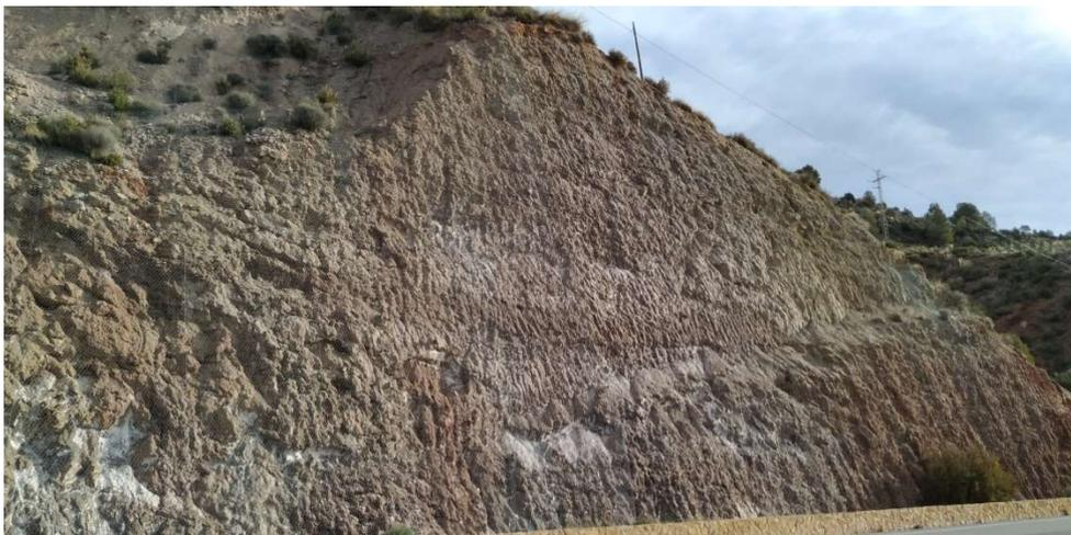
Figura 96: Talud en la carretera CV-50 en la comarca de los Serranos estabilizado con mallado metálico. Elaboración propia.
