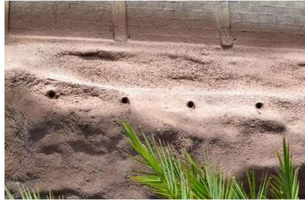
Figura 94: Izq. hormigón proyectado o gunita. Dcha. drenajes en la superficie del talud. Fuente, empresa Bulcanarte.
