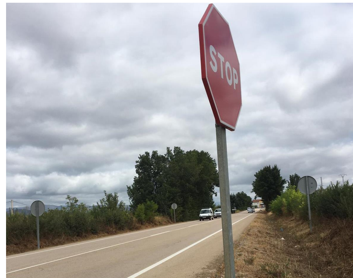
Figura 14: Intersección sin visibilidad. (Fuente: Propia)
