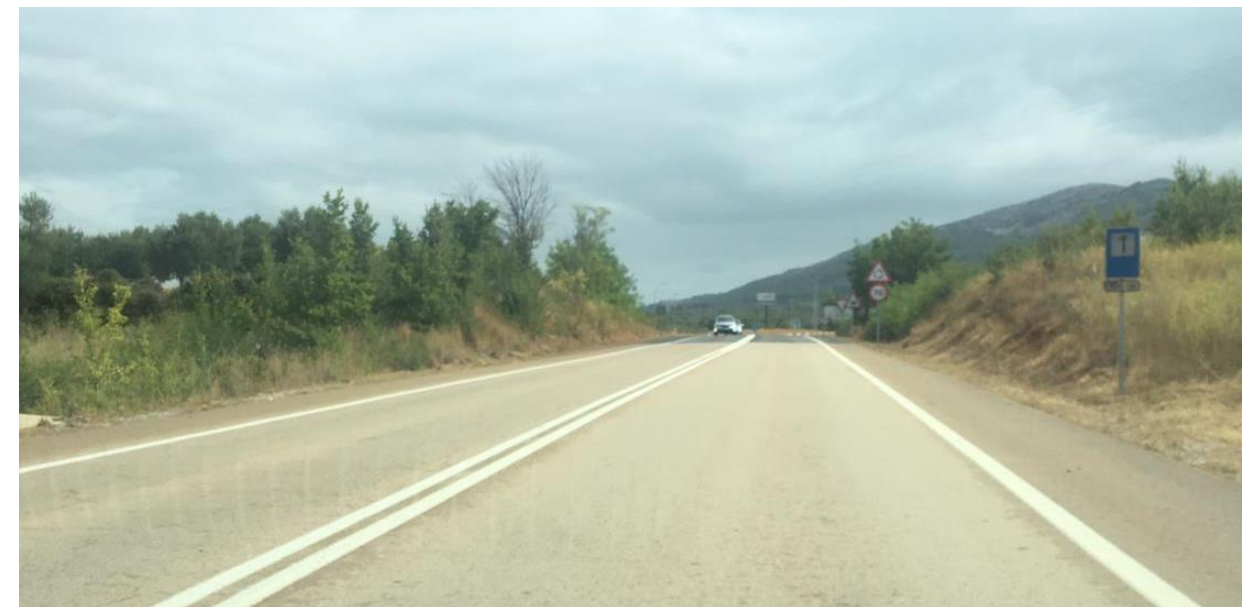
Figura 12: Sección de la carretera en el transcurso de la carretera. (Fuente: Propia)
