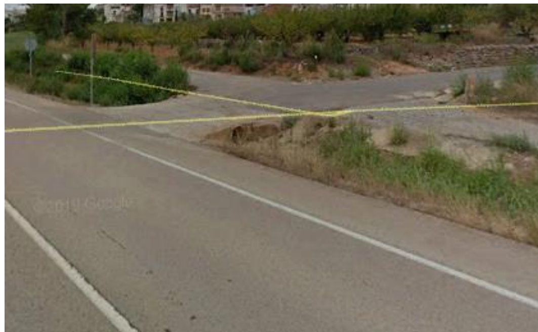
Figura 24: Obra de drenaje longitudinal en intersección (Fuente: Google Earth)
