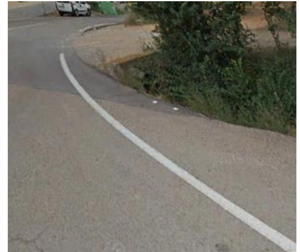
Figura 28: Obra de drenaje transversal en intersección (Fuente: Google Earth)
