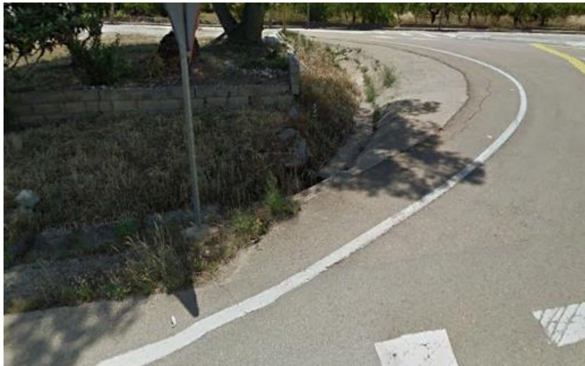
Figura 27: Obra de drenaje transversal en intersección (Fuente: Google Earth)
