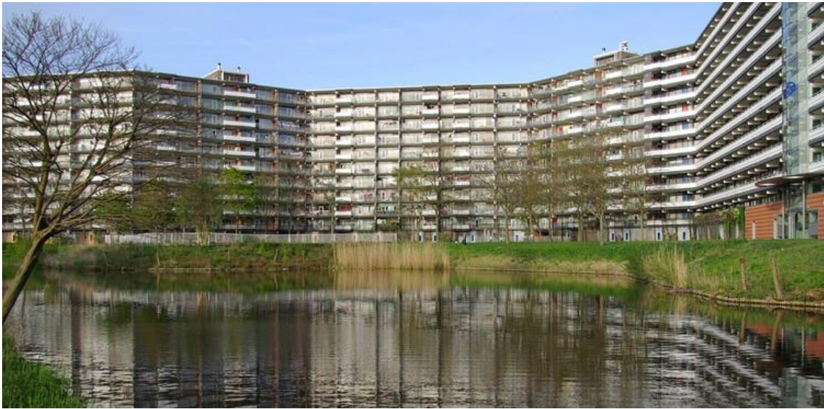
31. Lago artificial en el barrio de Bijlmermeer. NL Architects, XVW architectuur, 2017.
