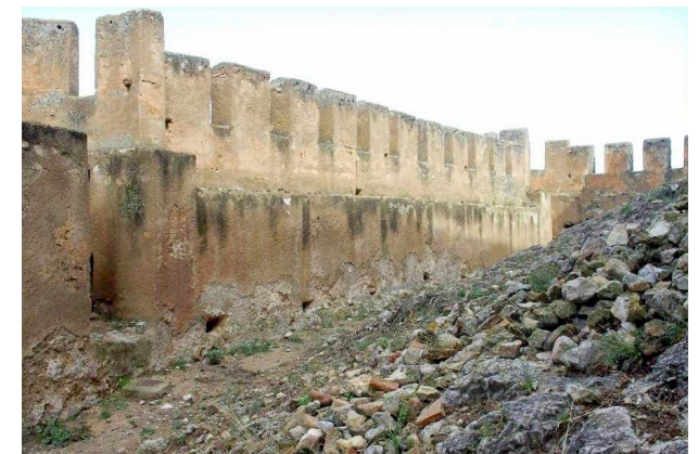
Fig. 113 Consolidación paso de ronda.
