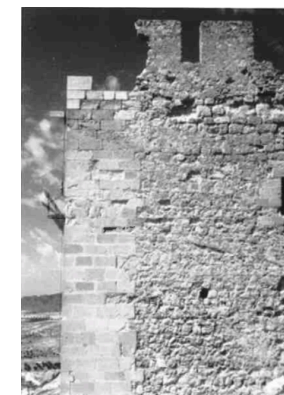
Fig. 81 Inicios de la reconstrucción del almenado
