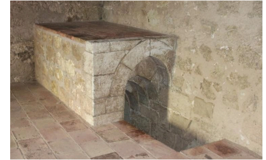
Fig. 57 Escalera interior de la Torre del Homenaje con bóveda escalonada de arcos apuntados.
