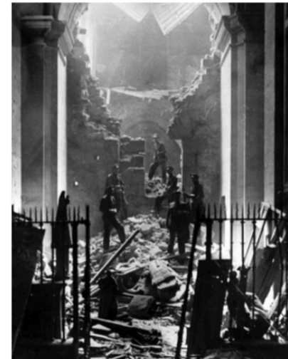
Fig. 12 Escombros de la voladura en la Cámara Santa de la Catedral e Oviedo
