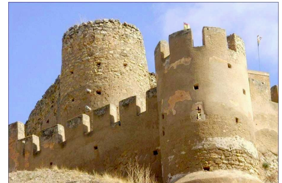
Fig. 115 Paramentos enfoscados con mortero de cemento..
