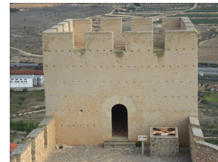
Fig. 60 Torre del extremo Este..
