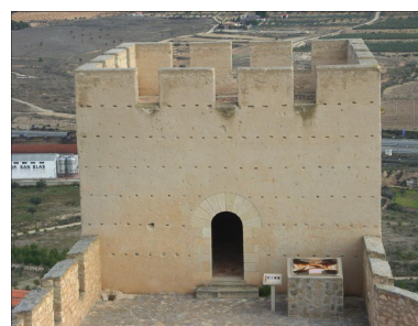
Fig. 97 Paramentos de la torre Este acabados. Se elimina la hornacina en forma de arco conopial.
