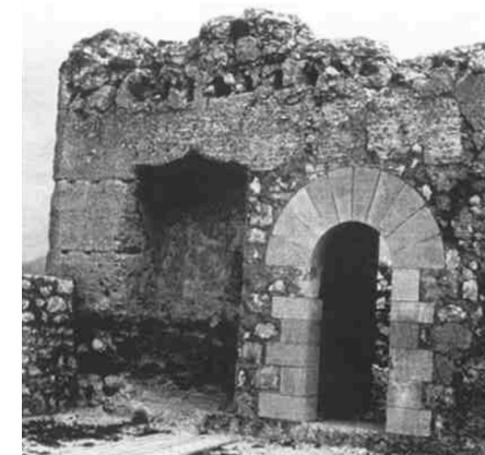
Fig. 62 Arco conopial existente en el alzado Oeste de la torre de origen árabe, antes de la restauración de Alejandro Ferrant.
