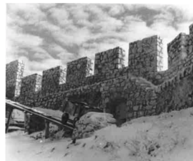
Fig. 86 Vista de la reconstrucción de la muralla del albacar desde el interior. Se puede ver la vagoneta sobre rieles para transportar materiales de una cota a otra.
