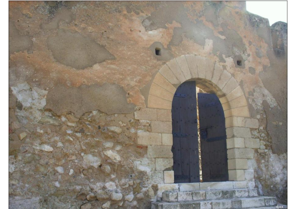
Fig. 114 Reconstrucción puerta de medio punto que da acceso desde el exterior con fábrica de sillería plana.
