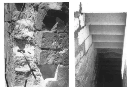
Fig. 84 Detalle durante la reconstrucción del arco exterior de la ventana meridional del último piso.
