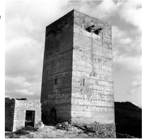
Fig. 74 Torre del Homenaje con la puerta de entrada de medio punto, antes de la restauración de Ferrant. A la izquierda de la torre aparecen las ruinas de la ermita..
