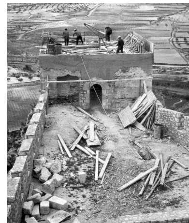
Fig. 96 Reparación en curso de los paramentos de la Torre Este. Se puede ver la muralla Norte y el bastión Sur ya reconstruidos.
