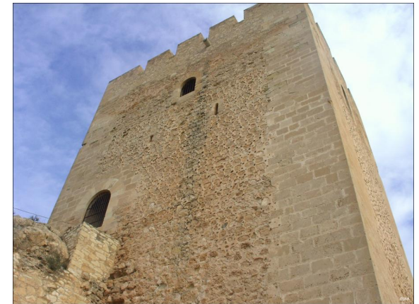
Fig. 56 Alzado Oeste conectado con el picacho del recinto inferior. Se puede observar el tipo de fábrica.
