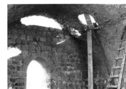
Fig. 93 Huecos de la bóveda de la planta superior vistos desde el interior.
