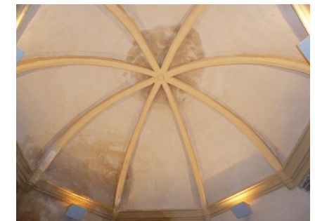
Fig. 76 Bóveda gallonada de la segunda planta.
