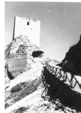
Fig. 78 Camino realizado mediante muro de mampostería en el recinto inferior que finaliza en la parte derrumbada del muro del albacar. Se aprecia también la falta de almenado de la Torre del Homenaje. apuntados.
