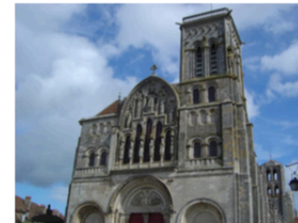
Fig. 19 Después de la restauración realizada por Viollet-le-Duc en la Abadía de Vezelay
