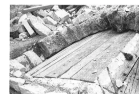
Fig. 94 Encofrado para reparar el hueco.
