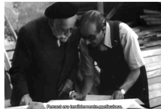
Fig. 35 Fotograma de Manuel Gómez Moreno y Alejandro Ferrant durante las obras del desmontaje del ábside de San Martín de Fuentidueña para su traslado, 1957.
