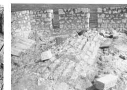
Fig. 95 Hueco reparado con sillería.
