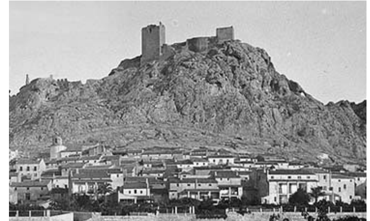
Fig. 77 Estado del castillo antes de la intervención de Alejandro Ferrant.
