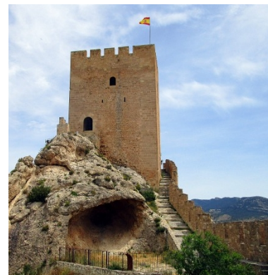
Fig. 90 Peldaños ya construidos adosados al lienzo Sur.
