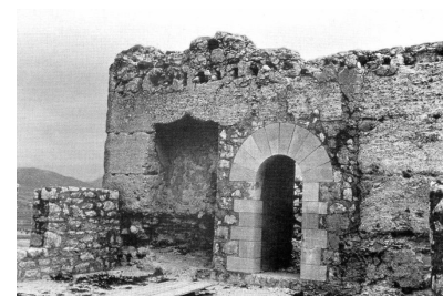
Fig. 92 Puerta de la torre Este después de su restauración.
