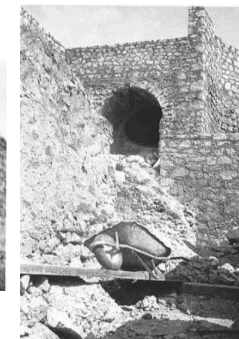
Fig. 102 Entrada del aljibe y bastión meridional después de su restauración.
