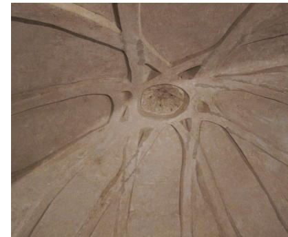
Fig. 75 Bóveda de la primera planta formada por ocho arcos apuntados-alanceados de marcados nervios. Conservada desde la época almohade..
