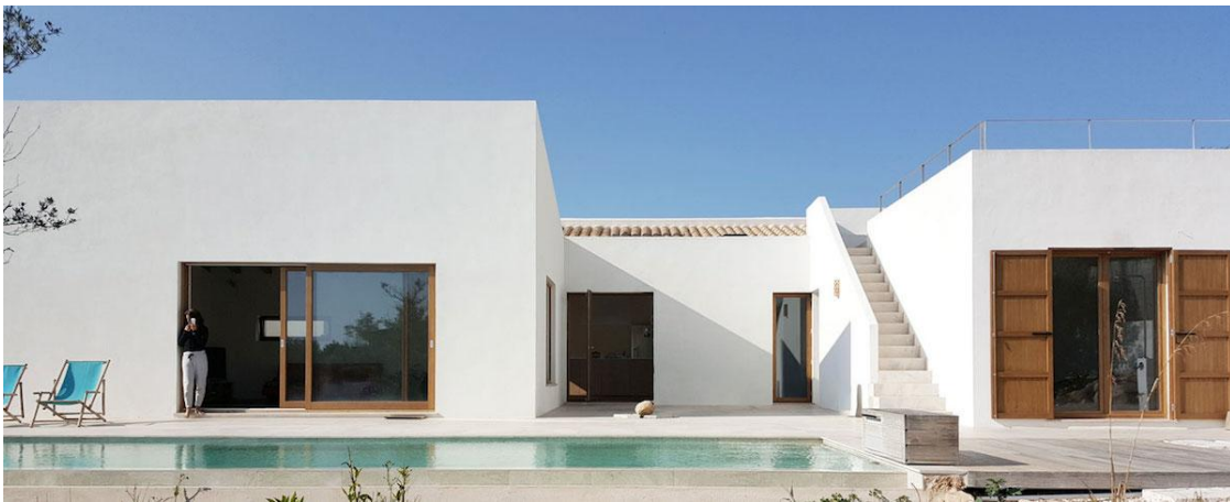
Fig. 19: Casa PI / Munarq arquitectes (2017)
