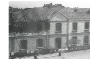
Derrumbamiento de la estación de ferrocarril de Aragón. _img. Estación
