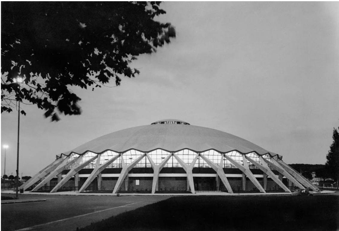
Figura 2: Palazzetto dello Sport, vista nocturna. Recuperado de: https://n9.cl/jwpa
