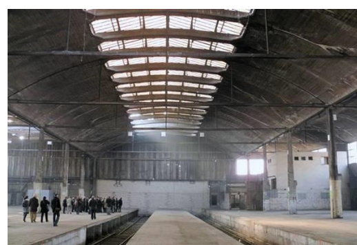
Figura 5: Halle de Messagerie de la Gare d'Austerlich. Recuperado de: https://n9.cl/0gsy
