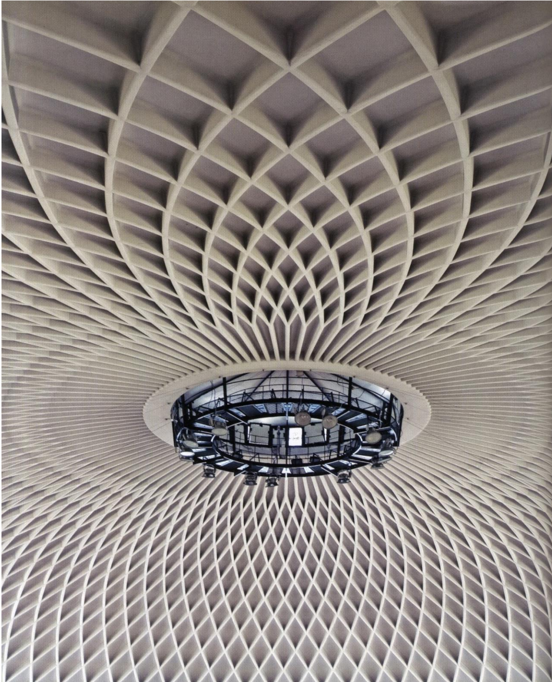
Figura 12: Intradós cúpula del Palazzetto dello Sport. Fuente: Iori, 2009.
