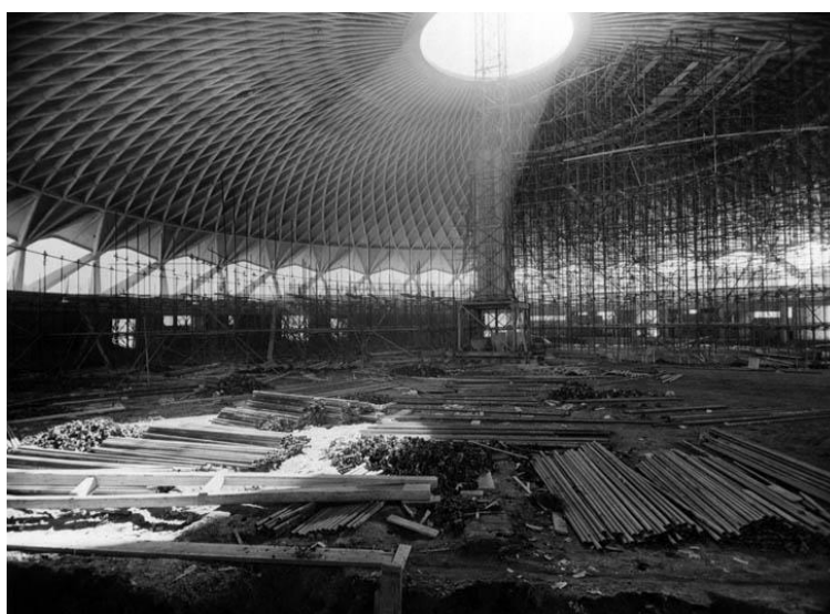
Figura 82: Vista interior etapa constructiva. Fuente: Iori, 2009.
