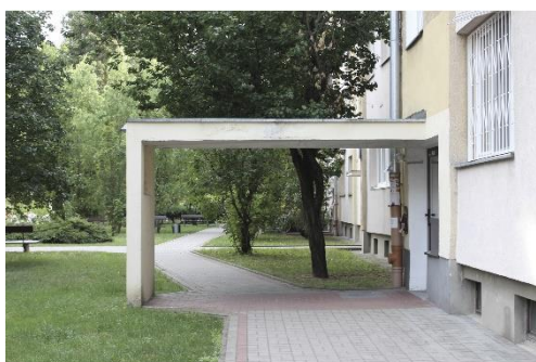
Ilustración 82. Detalle de entrada a las viviendas. Foto propia, mayo 2019
