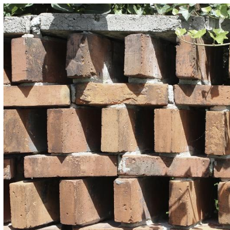
Ilustración 34. Barbara y Stanislaw Brukalski, Casa propia en Żoliborz. Detalle de celosía de ladrillo del límite con la calle. Recurso distintivo utilizado por los arquitectos. Foto propia, junio 2019
