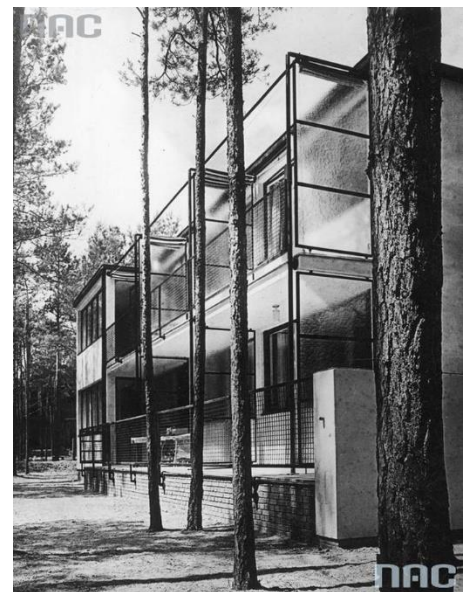
Ilustración 51. Helena Syrkus, Residencia para el Dr. Bernstein en Konstancin, cerca de Varsovia, 1931. Recuperada de "Architectural Association quarterly: the international journal for architectural ideas"
