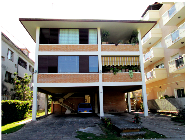
Img. 06. Edificio de Josefina Odoardo, La Habana. (foto tomada en 2013).
