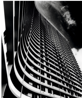
Fig. 5. Edificio FOCSA (1956) Sampera y Domínguez.
