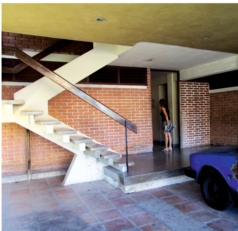
Img. 07. Edificio de Josefina Odoardo, La Habana. (foto tomada en 2013).
