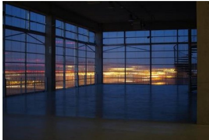
Fig. 135. Transparencia fachada desde interior, ENSAN.
