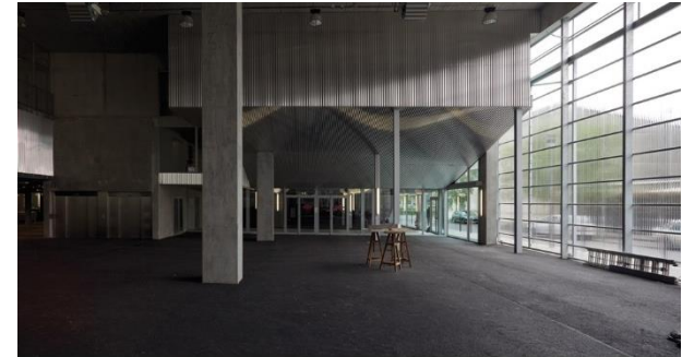
Fig. 143. Pérdida de la flexibilidad en planta baja, ENSAN.
