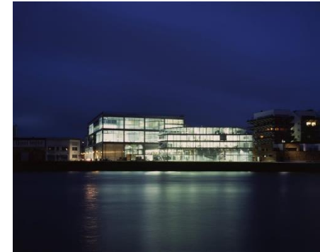
Fig. 112. Vista frontal con el entorno desde el río, ENSAN.
