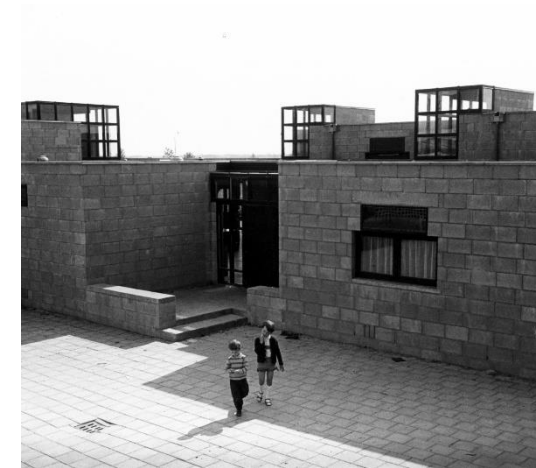
Fig. 74. Entrada principal, Escuela Montessori Delft.
