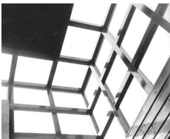
Fig. 85. Claraboya entrada aula, Escuela Montessori Delft.
