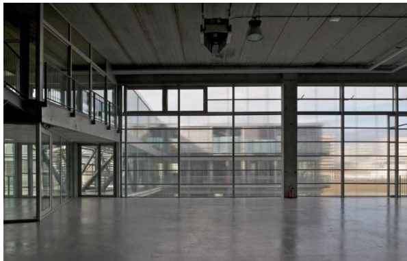
Fig. 130. Estructura secundaria metálica, ENSAN.
