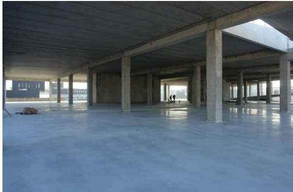
Fig. 128. Estructura principal de hormigón, ENSAN.
