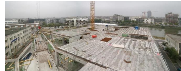
Fig. 128. Proceso constructivo, ENSAN.
