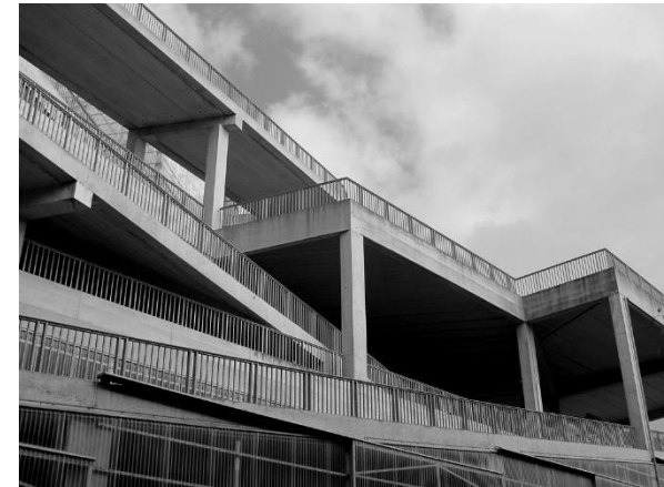
Fig. 132. Rampas exteriores, ENSAN.
