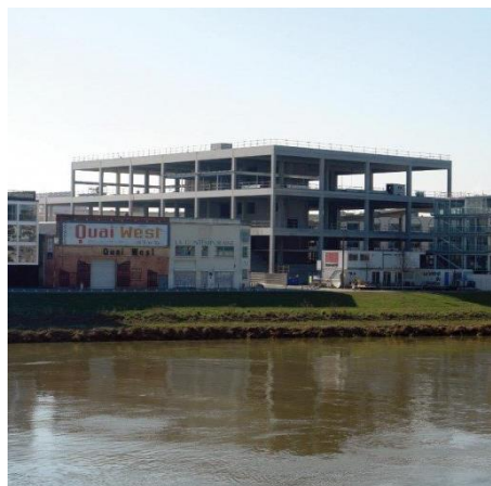
Fig. 116. Apilamiento de los forjados de hormigón, ENSAN.
