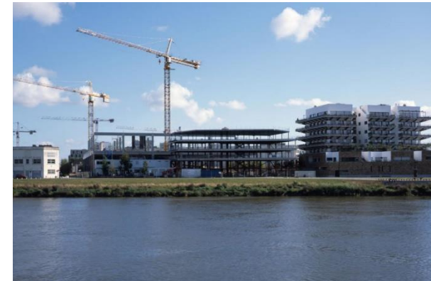
Fig. 127. Proceso constructivo, ENSAN.
