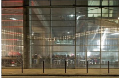
Fig. 134. Transparencia fachada desde exterior, ENSAN.
