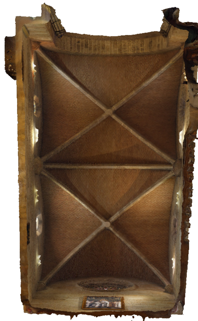
Fig.186. Modelo 3D Photoscan. Vista cenital bóvedas del coro. [Imagen propia, 2019]
