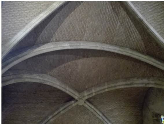
Fig.217. Arco central perpiño del coro. [Imagen propia, 2018]
