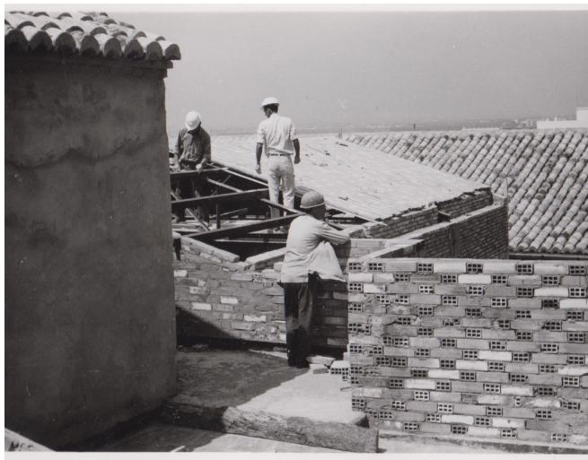
Fig.128. Construcción de la cubierta del coro. [Archivo histórico del Monasterio de El Puig, 1968]
