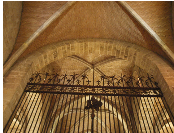
Fig.218. Arco rebajado de la entrada al coro. [Imagen propia, 2018]
