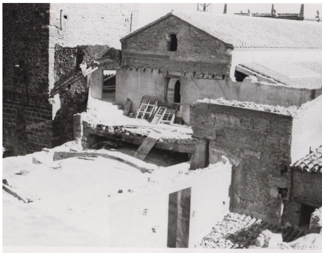
Fig.117. Desmante del antiguo coro quedando vista la fachada oeste de la nave central de la iglesia. En ese punto se construiría el paso superior en la cubierta del coro. [Archivo histórico del Monasterio de El Puig, 1968]
