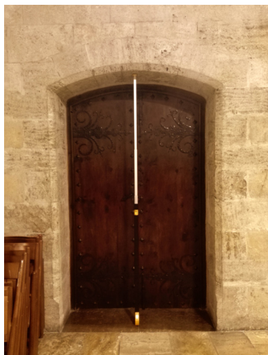
Fig. 150. Medición de la altura de la puerta sur con telescopio. [Imagen propia, 2018]
