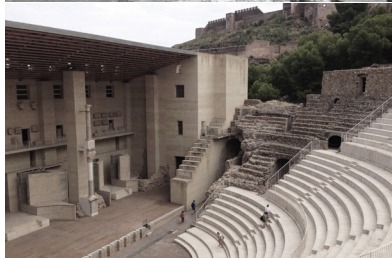
Fig.72. Teatro romano de Sagunto, antes (1984) y después de la restauración de Grassi y Portacelli. [Macarrón Miguel, A.M., 2007]
