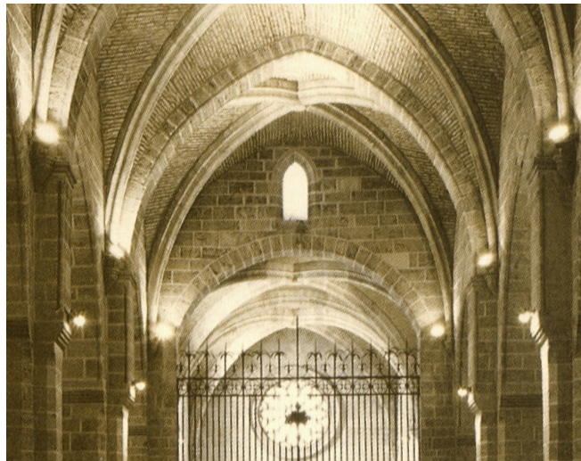
Fig.47. Arco perpiñaño o fajón ojival en la nave central (1er plano), arco rebajado en la entrada al coro (2º plano) y arco de medio punto entre las bóvedas del coro (3er plano). [Fotografía: Domínguez, 1992]
