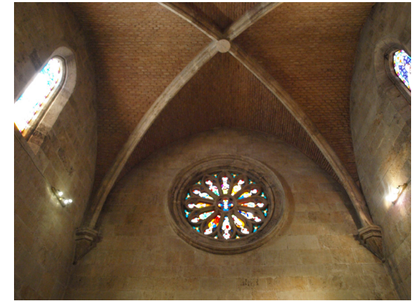
Fig.219. Arco formero ciego del muro oeste del coro. [Imagen propia, 2018]
