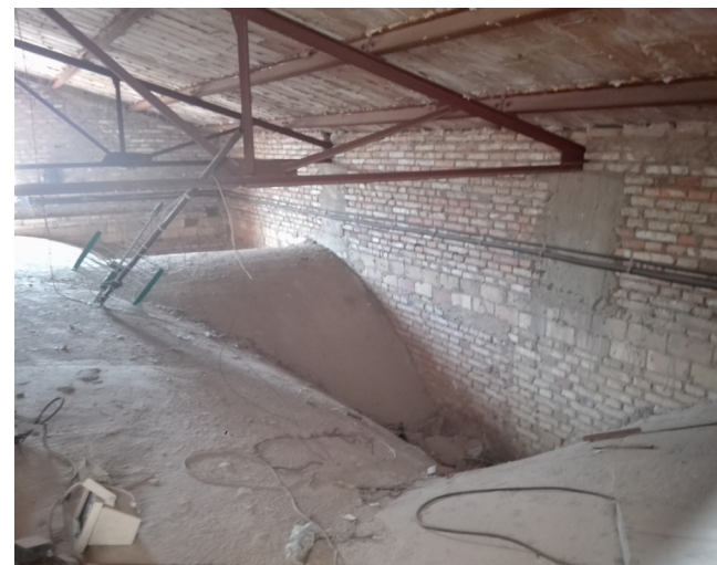
Fig.115. Trasdós de las bóvedas de crucería realizadas en la restauración de 1968. [Imagen propia, 1/2/18]
