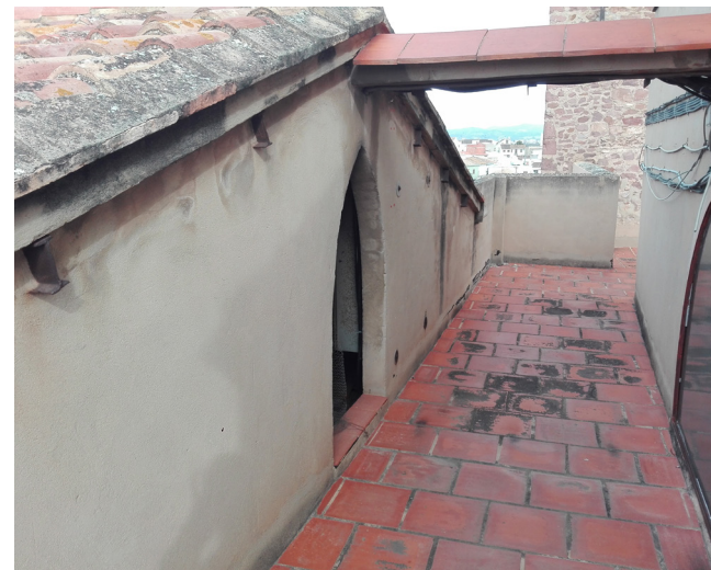
Fig.118. Paso superior en la cubierta. A la izquierda la cubierta ventilada a dos aguas del coro. A la derecha ventana que corona el arco de entrada al coro e ilumina la nave central. [Imagen propia, 1/2/18]
