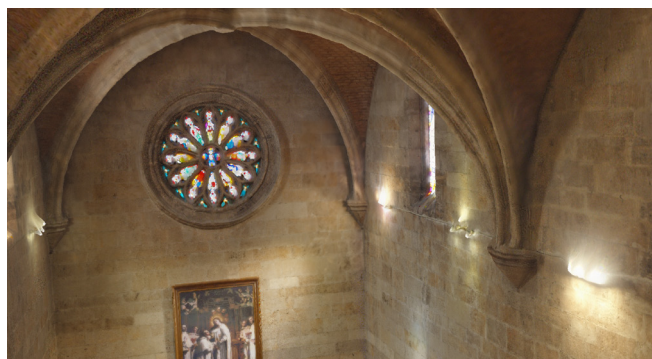
Fig.191. Modelo 3D Photoscan. Vista a la altura de las ménsula. [Imagen propia, 2019]
