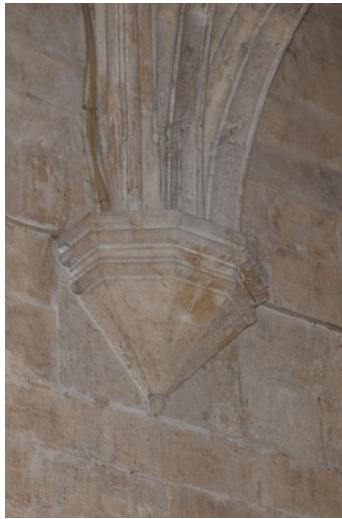
Fig.204. Fotografía de una de las ménsulas de pared. [Imagen propia, 2018]
