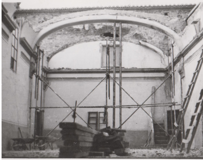
Fig.19. Demolición de los arcos fajones del coro del s.XVII. [Archivo histórico del Monasterio de El Puig, 1968]
