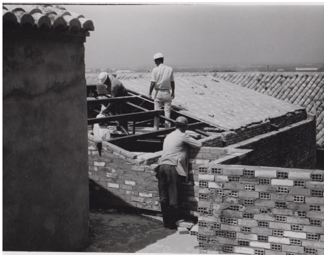
Fig.136. Construcción de la cubierta y del patio contiguo. [Archivo histórico del Monasterio de El Puig, 1968]
