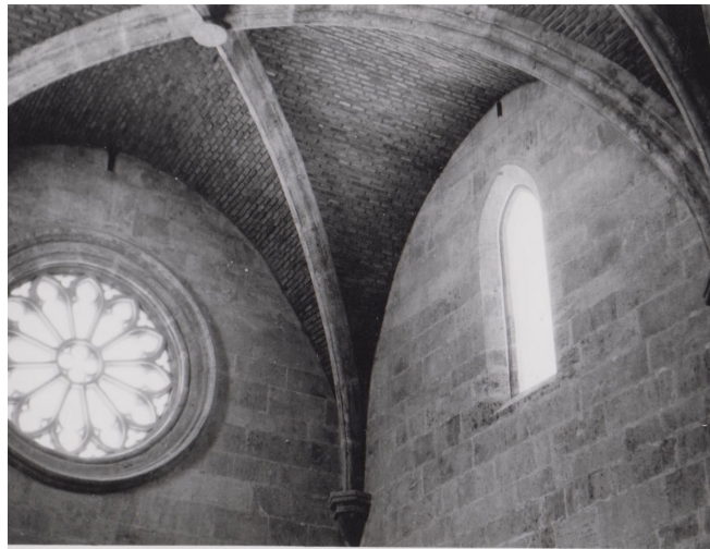
Fig.49. Arcos formeros ciegos ovales o apuntados rebajados, arcos de bóveda ovales o elípticos y bóveda de crucería simple. [Archivo histórico del Monasterio de El Puig, 1968]
