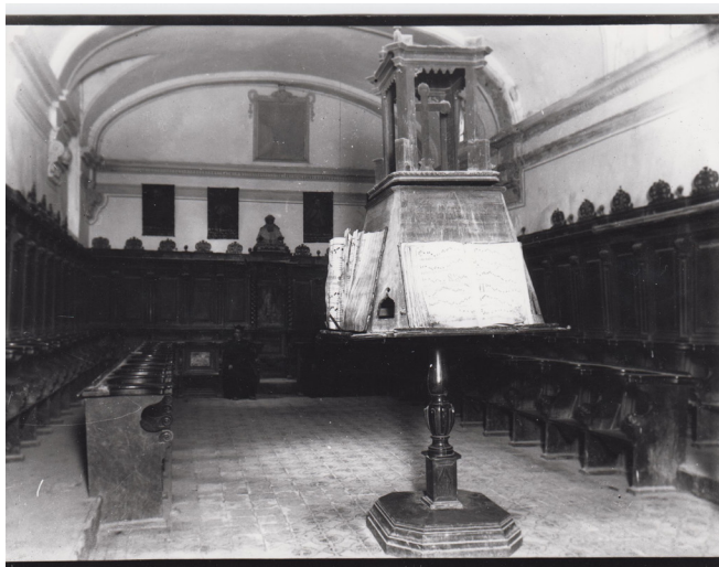
Fig.21. Antiguo coro construido en 1669. Bancada en U y facistol en el centro. [Archivo histórico del Monasterio de El Puig, 1915]
