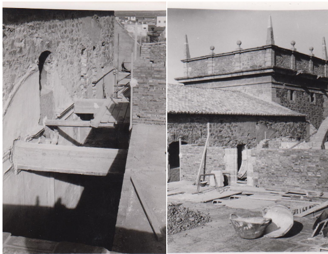
Fig.124. A la izquierda: separación del coro de la fachada del Monasterio. A la derecha: construcción del rosetón en el muro oeste. [Archivo histórico del Monasterio de El Puig, 1968]
