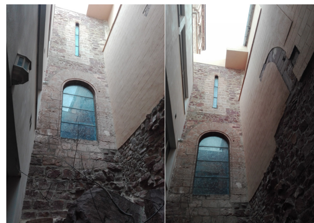
Fig.139. Patio junto al muro norte. Se puede apreciar en la restauración del muro el vestigio de la antigua puerta lateral. [Imágenes propias, 2018]
