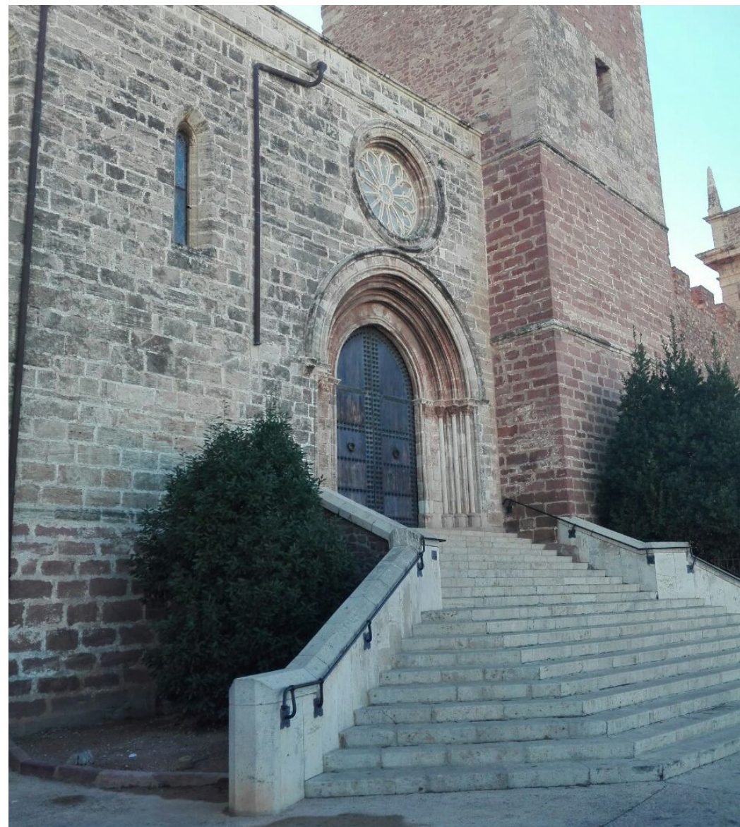
Fig.89. Entrada a la iglesia de Santa María de El Puig. [Imagen propia, 2018]
