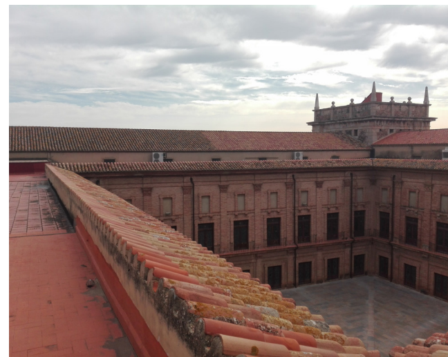
Fig.97. Cubierta del patio del Monasterio de El Puig. [Imagen propia, 2018]
