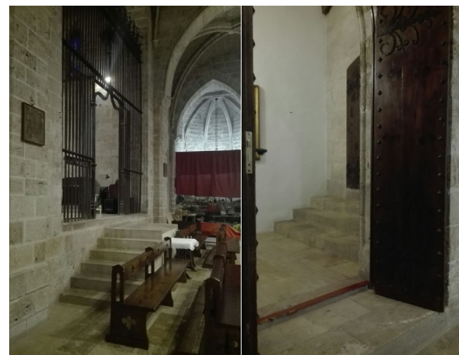
Fig. 135. Entrada principal este y entrada secundaria sur desde la nave lateral de la iglesia. [Imágenes propias, 3/1/2018]
