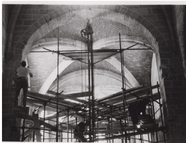
Fig. 133. Andamiaje para la construcción de las bóvedas del coro. [Archivo histórico del Monasterio de El Puig, 1968]
