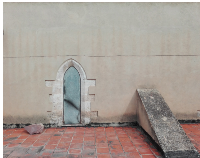
Fig.123. Trasdós del muro sur, con el contrafuerte a la altura del arco central. [Imagen propia, 1/2/18]
