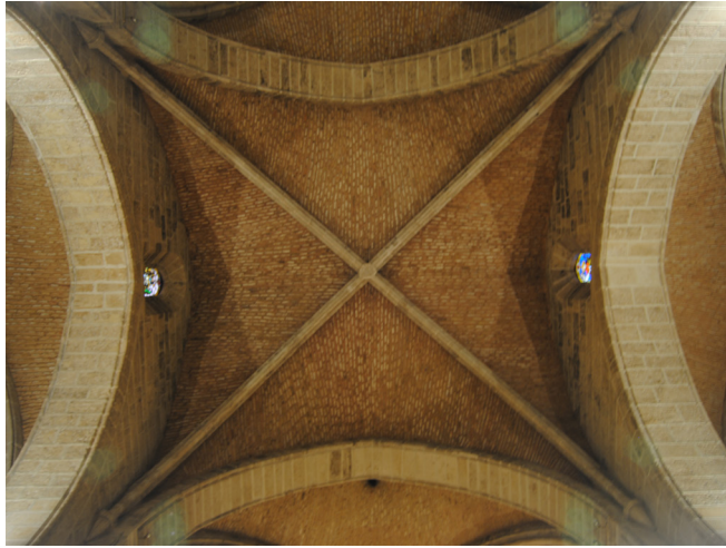
Fig.54. Bóveda de crucería de la nave central de la iglesia de El Puig. [Imagen propia, 2018]
