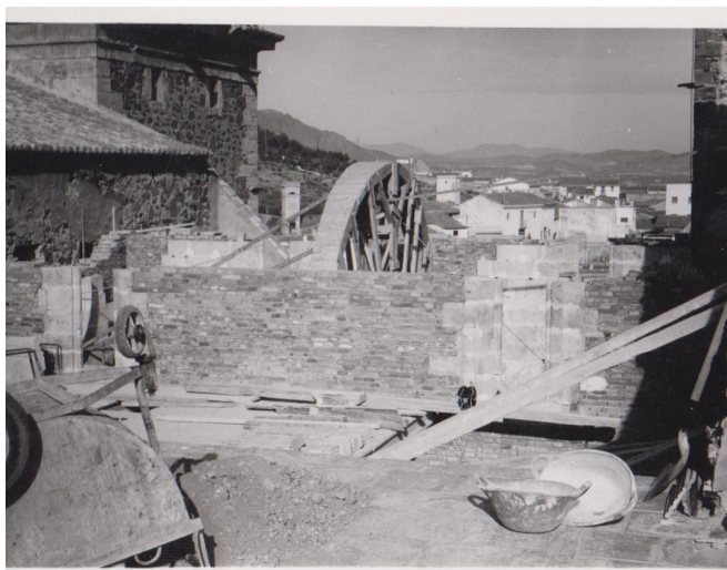
Fig.129. Construcción del arco central del coro. [Archivo histórico del Monasterio de El Puig, 1968]
