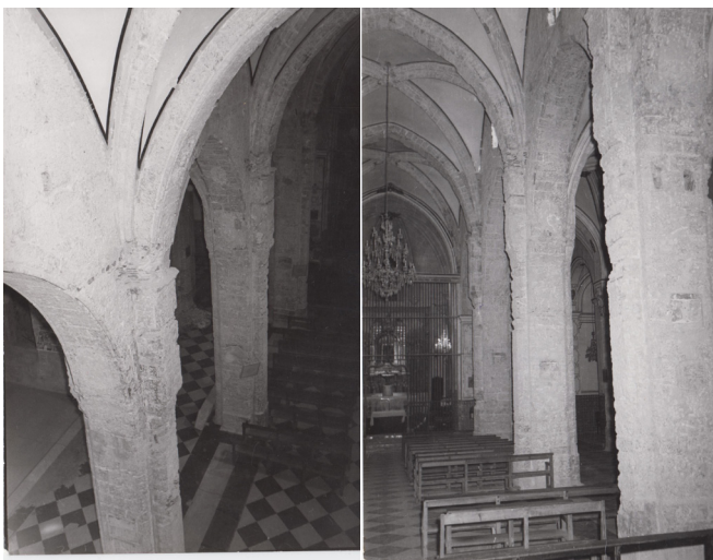
Fig.104. Nave central de la iglesia en su restauración. [Archivo histórico del Monasterio de El Puig, 1970]
