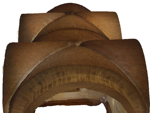
Fig.187. Modelo 3D Photoscan. Bóvedas del coro. [Imagen propia, 2019]
