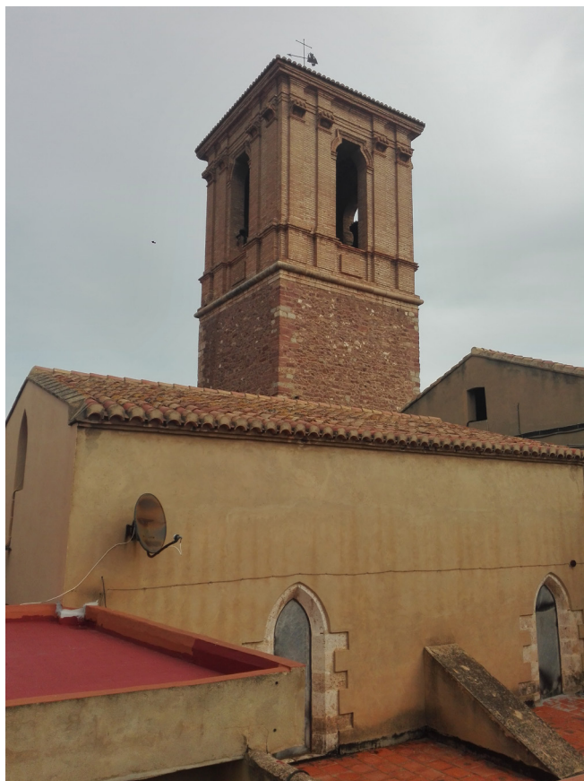
Fig.246. Vista exterior sur-oeste del coro. [Imagen propia, 1/2/18]
