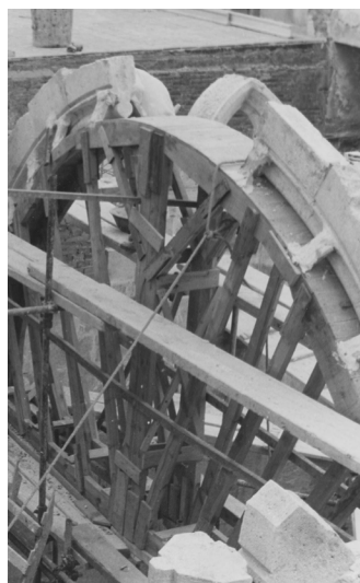
Fig.64. Cimbrado del arco de medio punto perpiña del coro. (izq.) [Archivo Histórico del Monasterio de El Puig, 1968], cimbra para un arco de medio punto. (arr. der.) [Plaza, Morales y Martínez, 2013, p.114] y cimbras para un arco oval y para un arco de medio punto. [Thunnissen, 2012]
