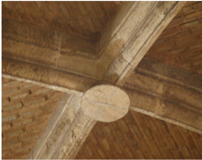
Fig.226. Detalle de la clave de la segunda bóveda del coro. [Imagen propia, 2018]
