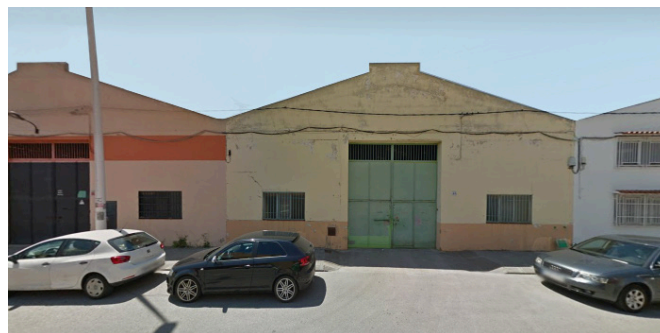
Fotografía de la fachada de una nave en desuso en la calle Camí a la Mar. Fuente: propia.
