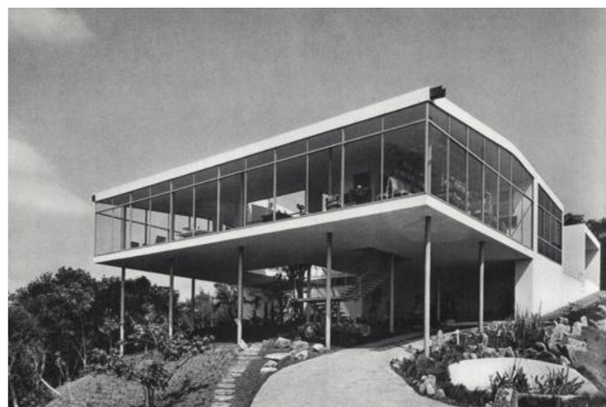
Casa de vidro
