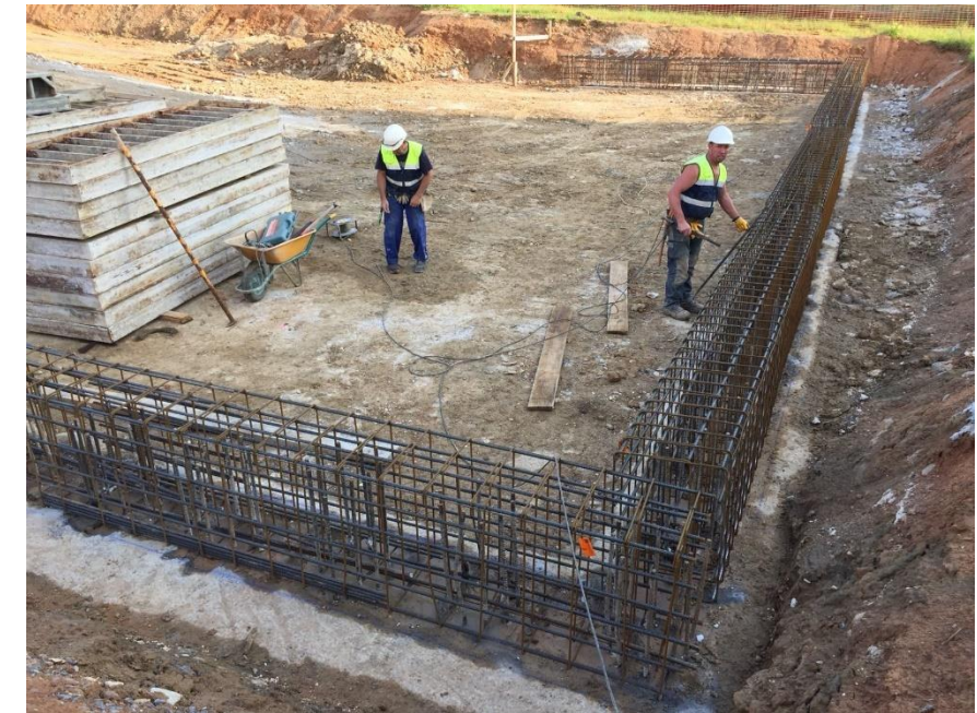
Figura 29. Ejecución de la viga de atado de los paneles FUENTE: Javier Torrijo
