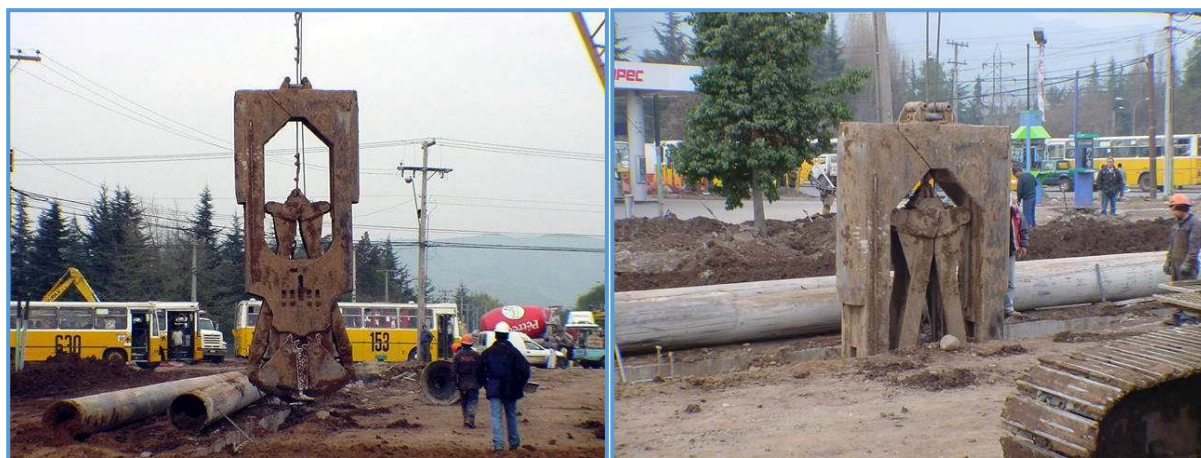
Figura 24. Perforación de la zanja. FUENTE: Javier Torrijo
