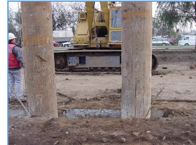
Figura 25. Colocación de los encofrados de las pantallas. FUENTE: Javier Torrijo
