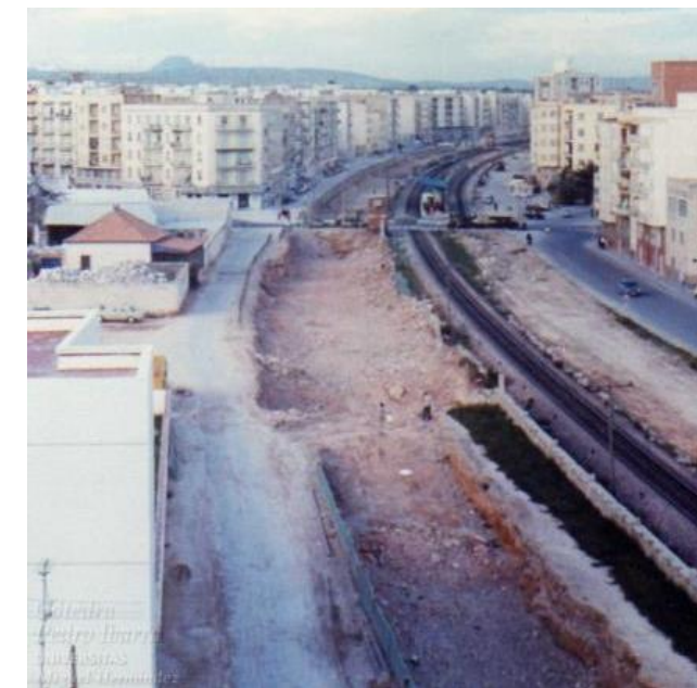
Figura 18. Obras de soterramiento del ferrocarril que atraviesa la ciudad Ilicitana.
