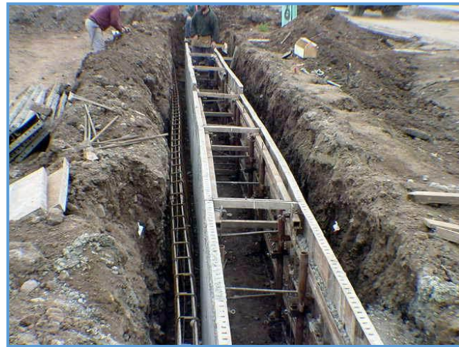
Figura 23. Ejecución de los Muretes Guía. FUENTE: Javier Torrijo
