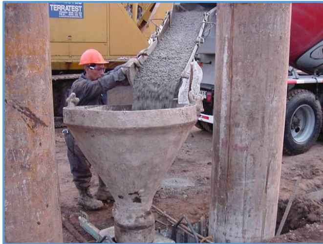
Figura 27. Hormigonado de las pantallas. FUENTE: Javier Torrijo
