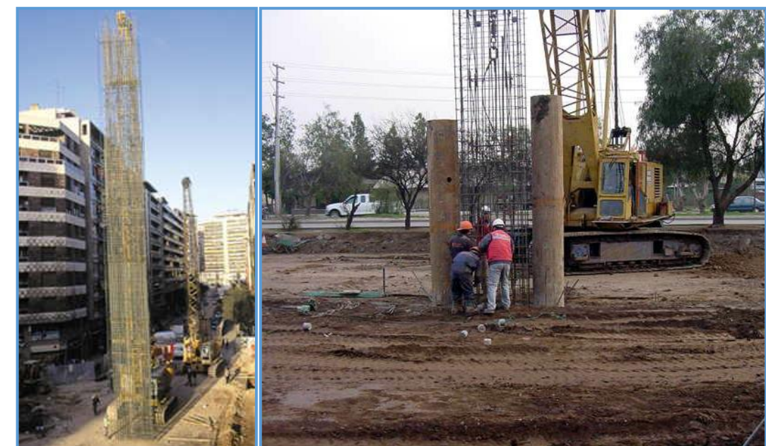
Figura 26. Colocación de las armaduras del panel. FUENTE: Javier Torrijo
