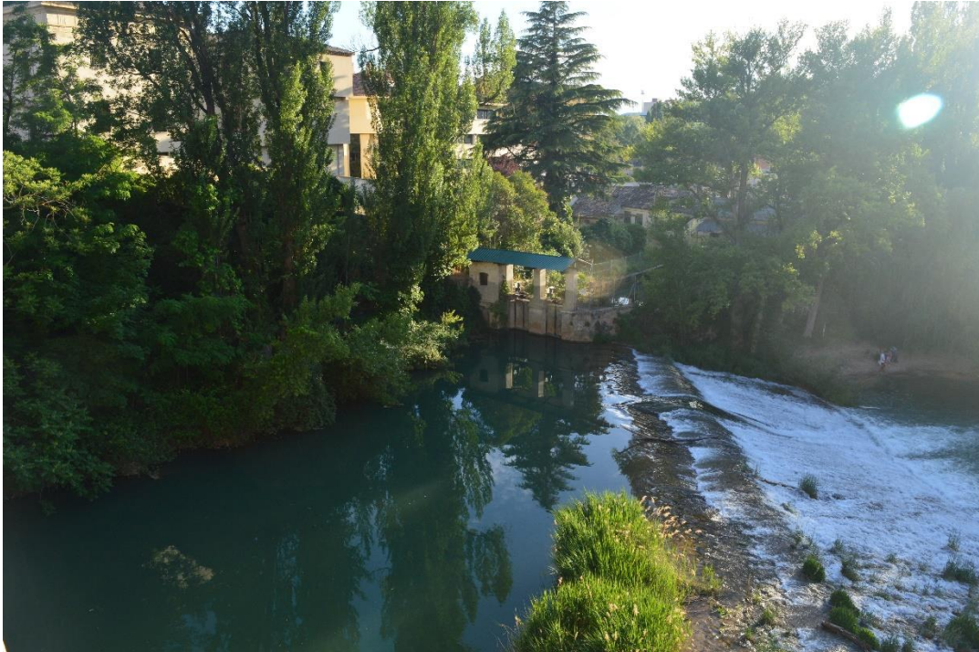
Figura 21. Central hidroeléctrica Molino de Santiago y subestación de Cuenca (Foto de Autor)
