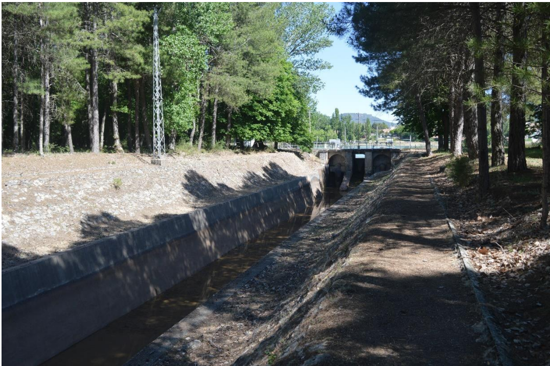
Figura 15. Bocal y canal industrial derivador desde Laguna de Uña hasta El Salto (Foto de Autor)
