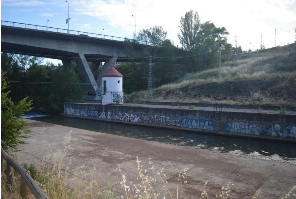
Figura 24. Estación de aforo de Cuenca con canal de aguas bajas y vertedero de pared delgada (Foto de Autor)
