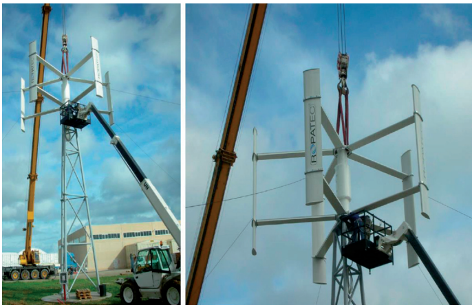
Fig. 5: Torre y turbina fotos de montaje
