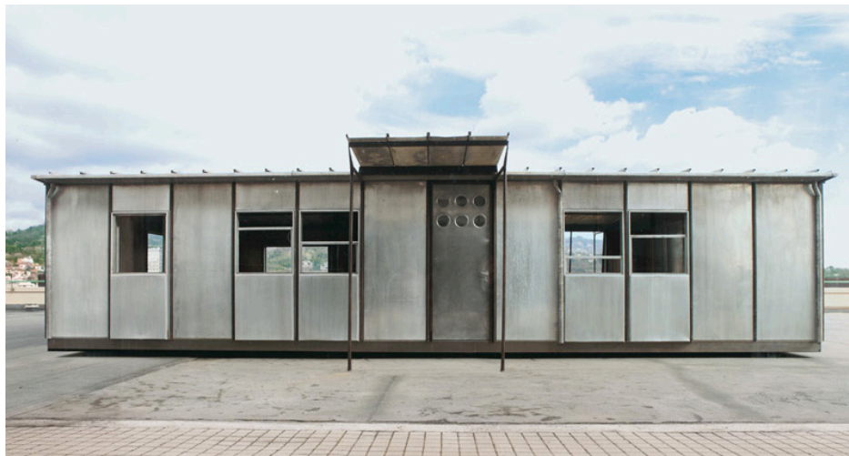
fig. 18 Sistema constructivo Metropol de Jean Prouvé
