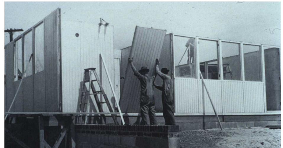
fig. 15 Montaje de las Packaged Houses de Walter Gropius
