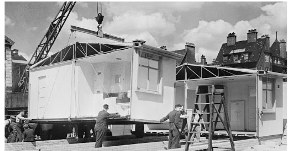
fig. 17 Montaje de las AIROH Houses
