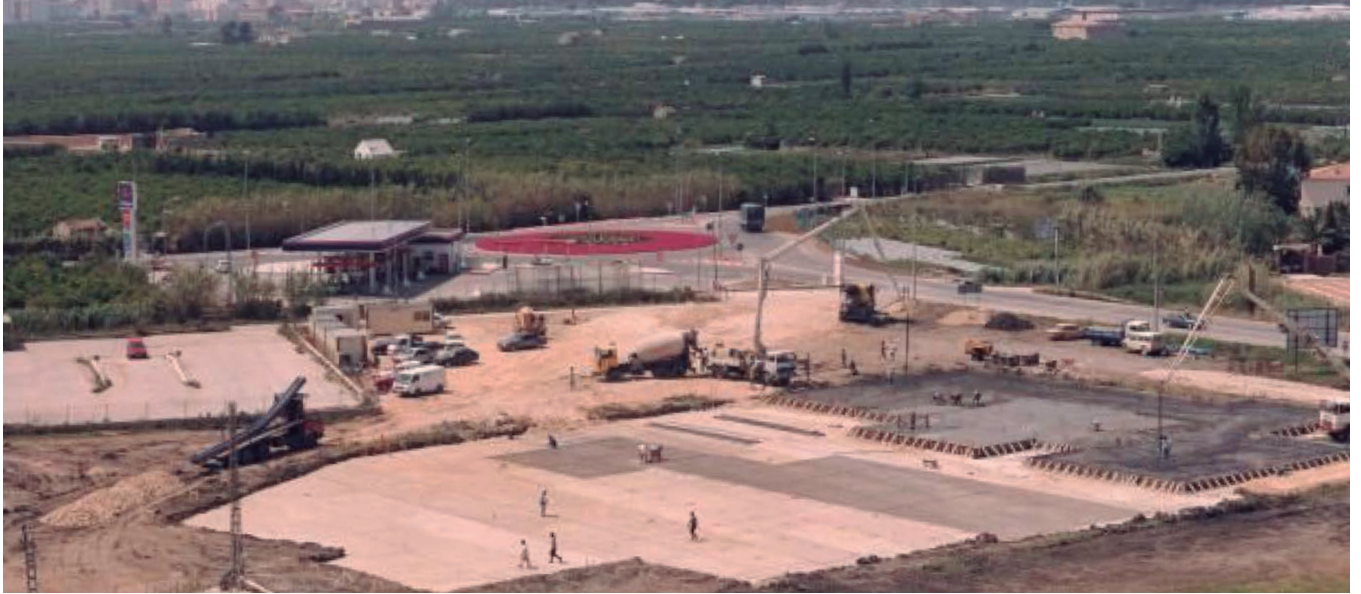
Comencen les obres 1994. ( Foto: Gente de la Safor)
