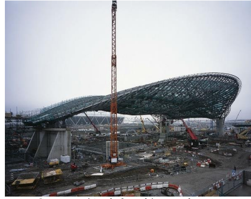
Imagen 30. Construcción de la cubierta sobre soportes.
