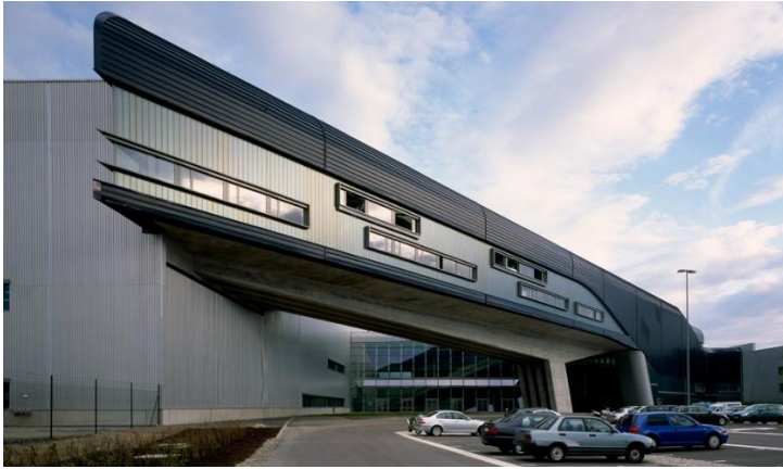
Imagen 6. BMW Central Building.
