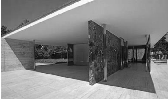
Fig.11: Mies Van der Rohe, Imagen exterior Pabellón Alemán. Barcelona. 1929
