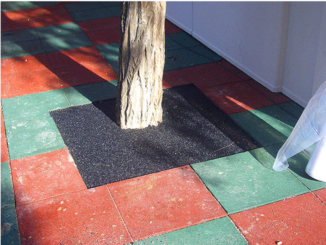
Alcorque relleno de caucho
