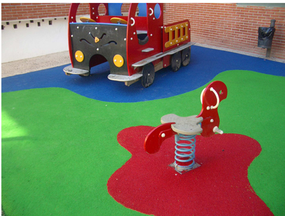
Pavimento de caucho continuo
