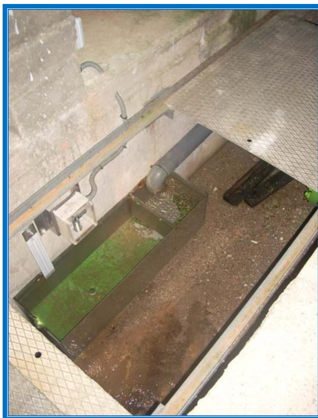
Fotografía 16: Aforador nº 2 (AF-2).Filtraciones de la margen derecha.
