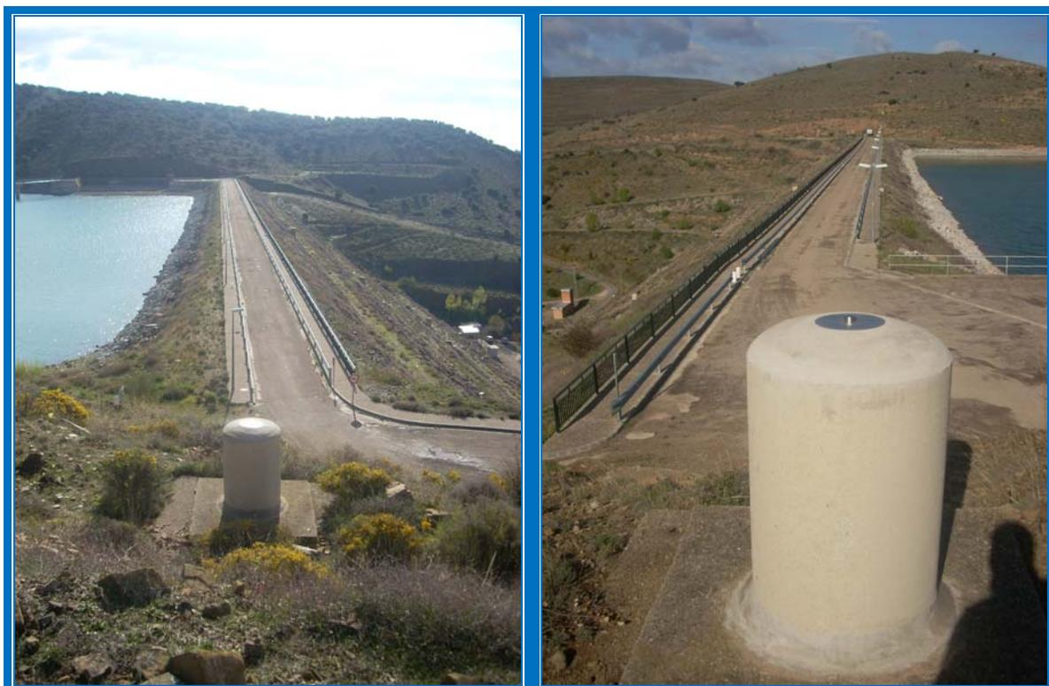
Fotografía 20: Pilares para campañas de colimación (margen derecha y margen izquierda)
