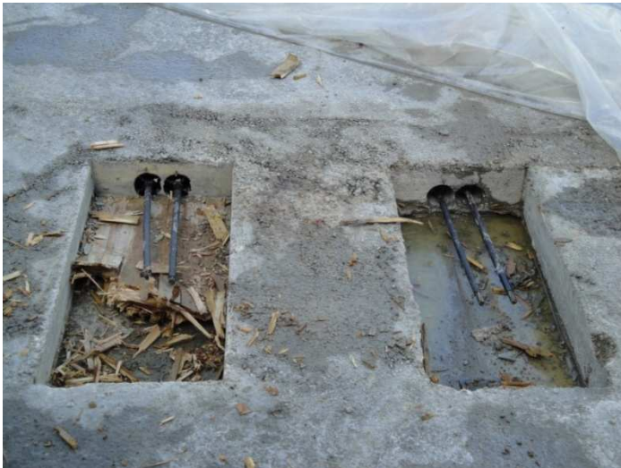
Curado del hormigón con utilización de plásticos.
