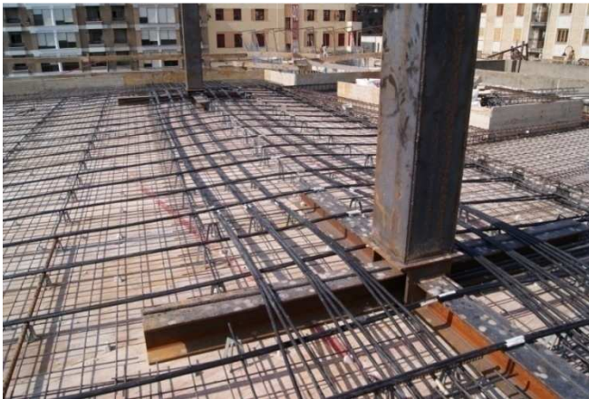
Trazado de cables sobre silletas.
