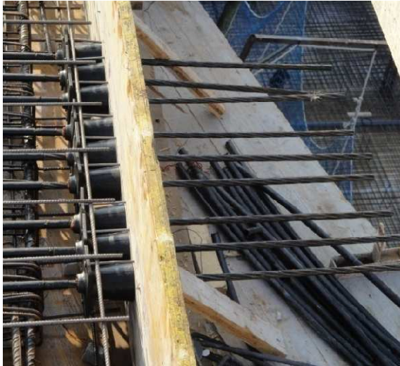
Zona de anclajes activos.
