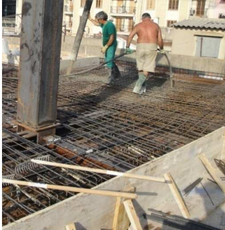
Vertido del hormigón mediante bomba y vibrado con aguja.
