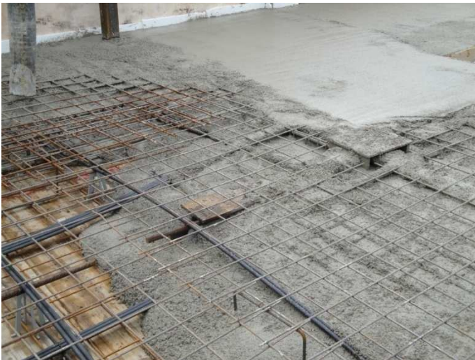
Hormigonado y vibrado con regla vibratora.
