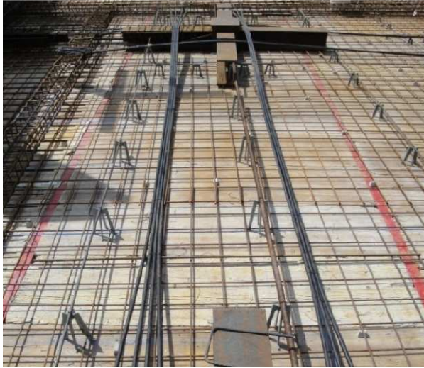
Colocación de silletas.
