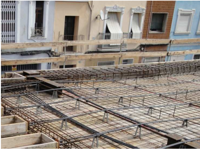
Imagen del empleo de sillas para definir la curvatura de los tendones.
