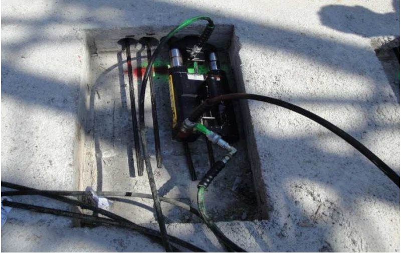
Momento del tesado con gato hidráulico.
