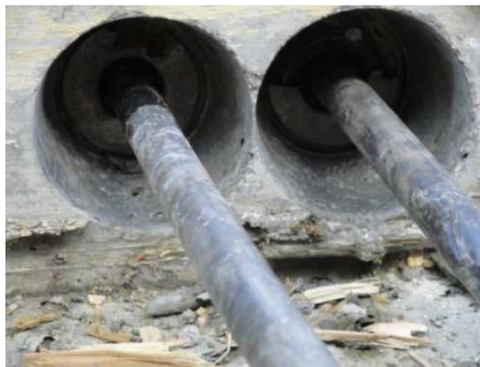
Eliminación del encofrado y del tapón de plástico.
