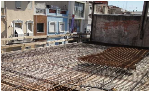
Colocación de la armadura pasiva superior sobre pates.
