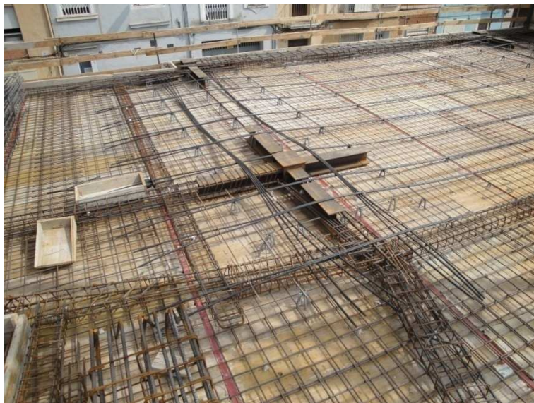
Armadura inferior pasiva, silletas y armadura activa.
