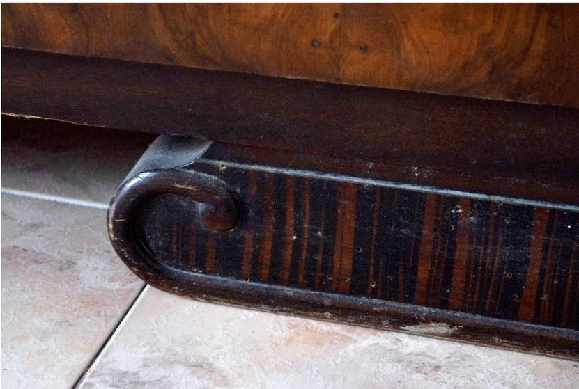
Fig. 203: Ataque *Anobium Punctatum* en la pata del *Armario*.
