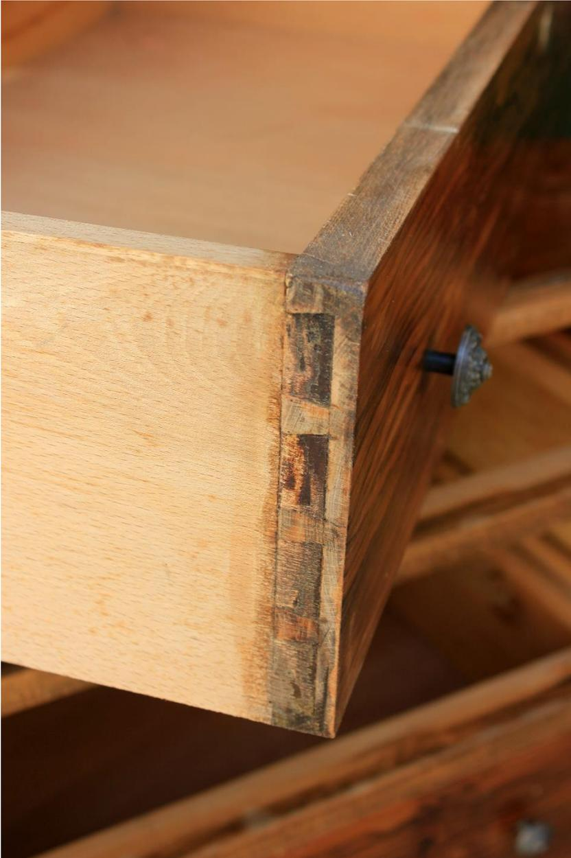
Fig. 193: Ensamblados de lazos vistos o de frente de cajón de la *Cómoda*.
