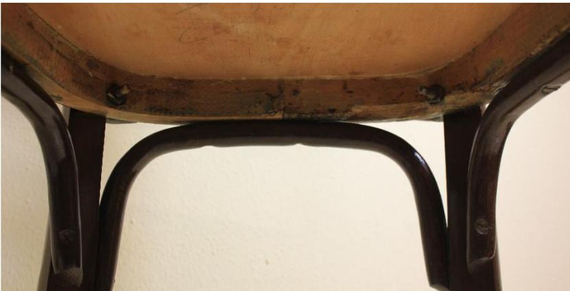
Fig. 129: Unión patas traseras al bastidor por medio de tornillería de la *Pareja de sillas 1*.
