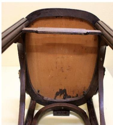
Fig. 141 y fig. 142: Detalle del travesaño e interior del bastidor de la *Silla 3*.
