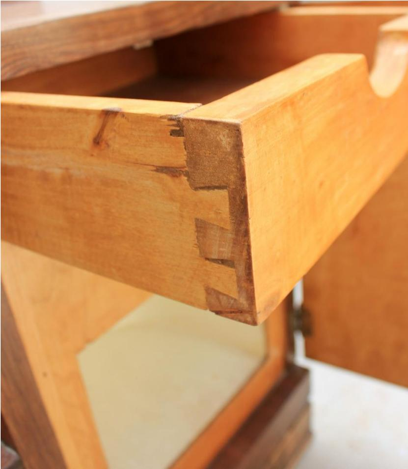
Fig. 189: Ensamblajes de lazos vistos o de frente de cajón de la *Mesita 5*.
