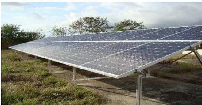
Figura 3. Generador Fotovoltaico CIES de 7.5 kWp.
