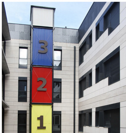
Fig.25. Uso de colores más saturados y contrastes resaltados, diferenciando elementos arquitectónicos. Residencia para Mayores, Madrid. 2010. Nueva planta. GEED Arquitectos. Fotografía Alfredo Prados Covarrubias. Fuente: GEED Arquitectos webpage
