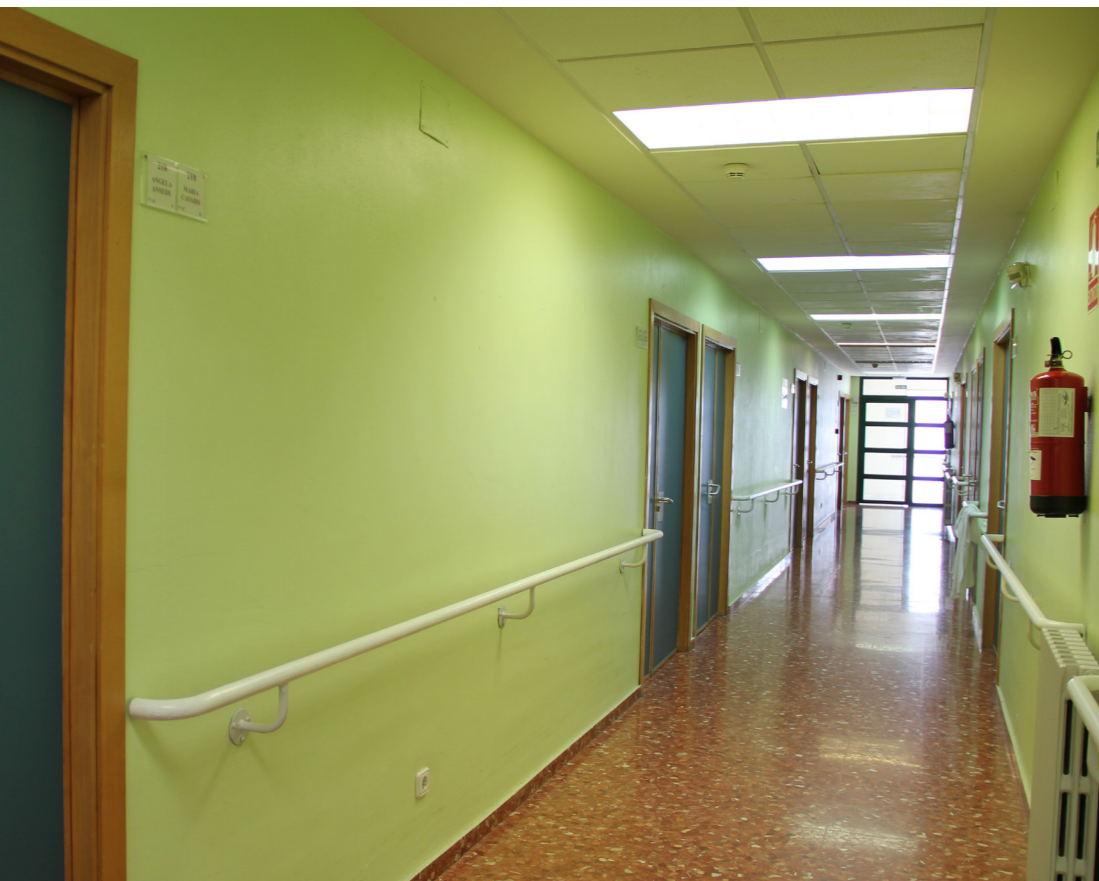
Fig.37. A la izquierda: Imagen de un pasillo de la “Residencia para personas mayores en Sagunto”, Valencia, tras la visita realizada. Imagen tomada durante el día, iluminación natural combinada con iluminación artificial. Fuente: Imagen realizada tras la visita a la residencia
