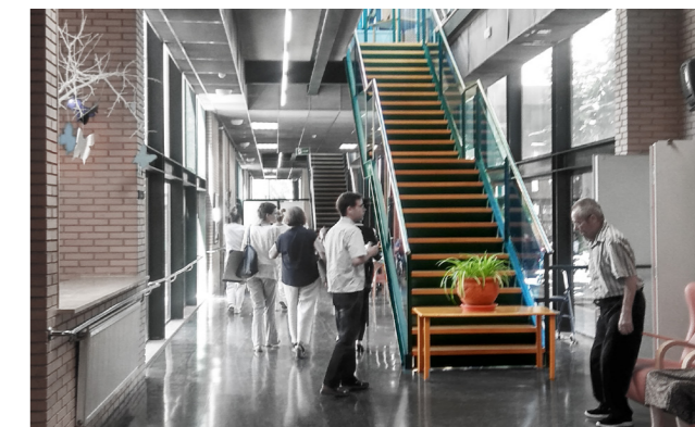
Fig.41. Las escaleras de comunicación interior han sido protegidas por una mesa y planta para evitar caídas. Ejemplo negativo de accesibilidad. Comunicación interior de la "Residencia PMD de Chiva", en Valencia. Fuente: Elaboración propia tras las visitas realizadas.
