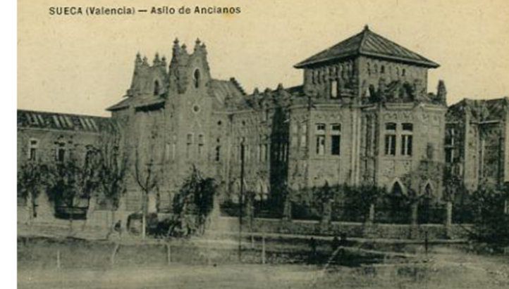
Fig.6. Asilo de Ancianos de Sueca, Valencia. Construido en 1919 destinado al cuidado de pobres, enfermos y niños. Arquitecto B.Ferrando Castells. Fuente: Postal antigua de todocolectión.
