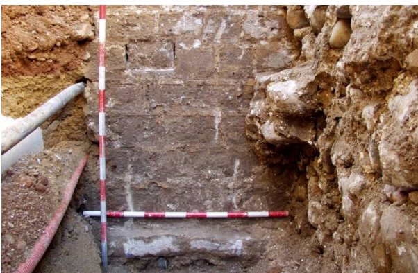
Figura 3. Paramento exterior de la muralla flavia, realizado en opus vittatum .
