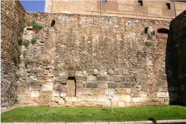
Figura 8. Lienzo de la muralla bajoimperial en el que se aprecia la obra original romana de sillería y mampostería cuarcítica con las fases constructivas posteriores.
