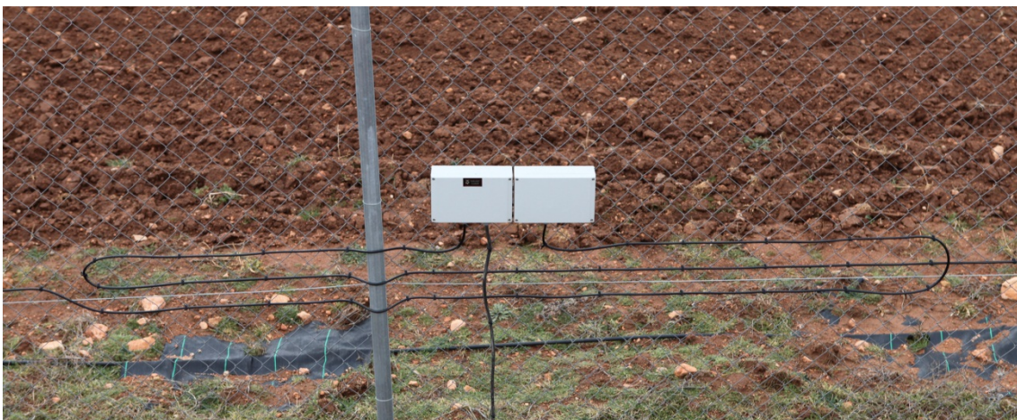
Figura 3. Detall del cable microfònic amb els corresponents analitzadors, situats en la tanca perimetral.
