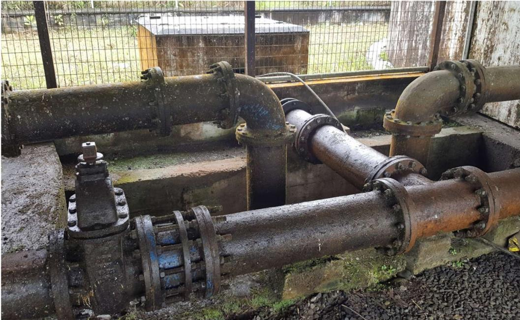
**Figura 19.** Válvulas a la llegada del depósito R2.
