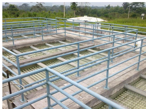
Figura 16. Sedimentador de Alta tasa.
