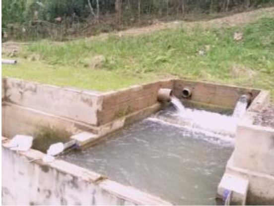
Figura 13. Cámara de entrada.
