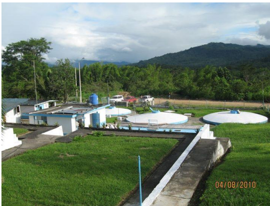
Figura 20. Tanques de almacenamiento de la Planta Antigua.
