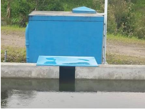
Figura 25. Cámara de entrada.
