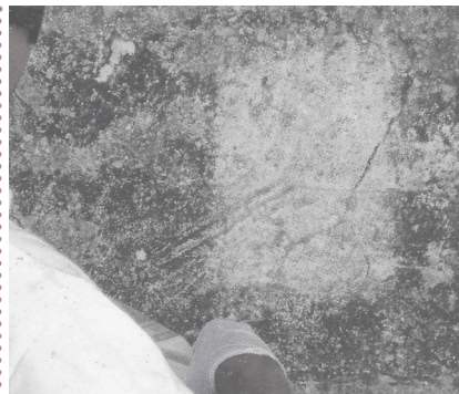
[F74] Cepillado de una fachada ennegrecida con biocida Fuente: Vegas, F., Mileto, C. (2014). Aprendiendo a restaurar.
