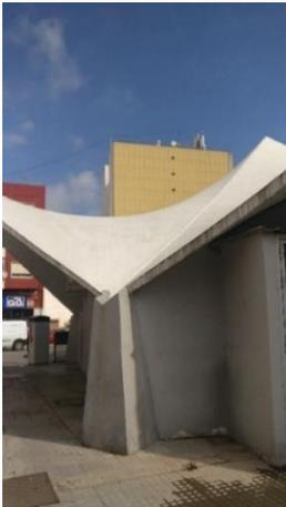
Otro punto clave a resaltar es la unión entre paraboloides hiperbólicos. En principio, no se especifica en el proyecto que debiera colocarse ningún tipo de armadura a modo de conexión entre ellos, como si cada uno de ellos funcionase estructuralmente de manera independiente.
