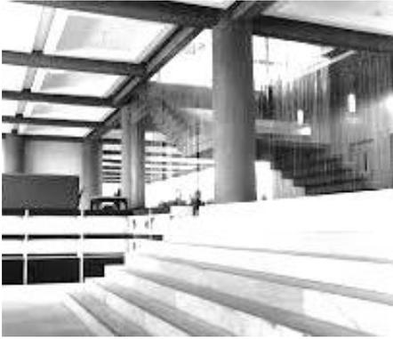
El vestíbulo se caracterizaba por la sencillez de la decoración y se extendía a varios niveles conectados por escaleras de hormigón armado visto en los cantos y revestidas de mármol blanco. La cortina de tensores de acero que envolvía la caja de escalera ofrecía transparencia y conexión entre espacios permitiendo el paso de luz.
