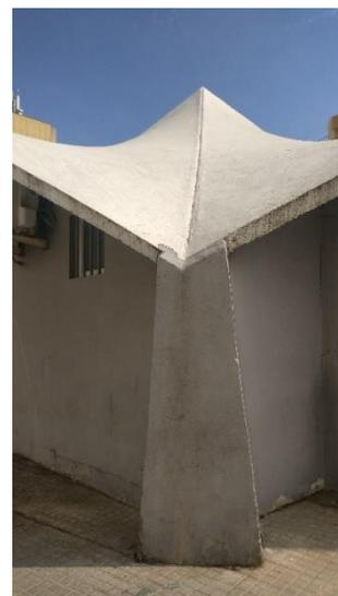
*Unión de dos paraboloides en la zona del apoyo. Fuente: Elaboración propia*
