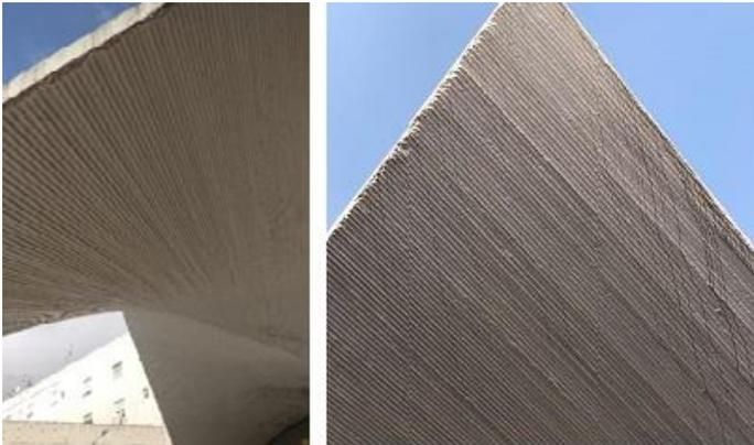
madera que siguen la dirección de las generatrices rectas y que sirven de encofrado, rematando con parapastas perimetral. Este encofrado recto consigue generar el paraboloide.
