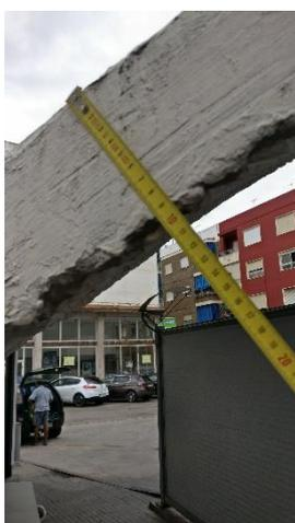
La principal característica de estas estructuras es que, gracias a que todos estos esfuerzos se producen en la superficie de la lámina, todos los esfuerzos pueden ser soportados con espesores mínimos.
