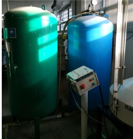
*Imagen 46. Deposito hidroneumático del laboratorio de hidráulica de la UPV*
