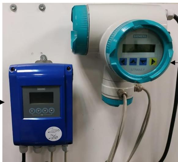
*Imagen 54. Caudalímetros electromagnéticos Krohne (izquierda) y Siemens (derecha)*
