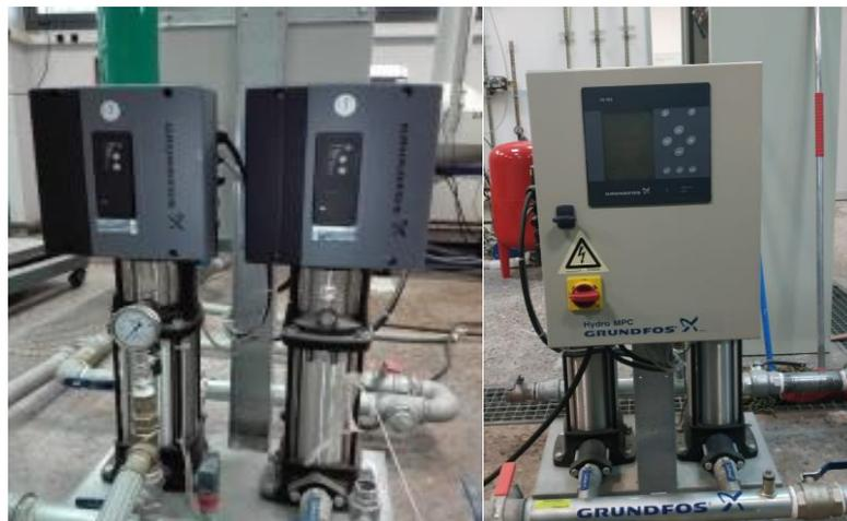
*Imagen 45. Equipo de bombeo para el banco de ensayos de contadores de la UPV*
