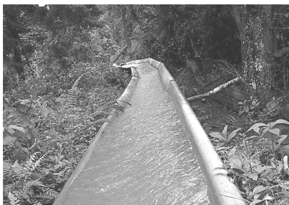
Figura 3. Canaleta de prueba.
