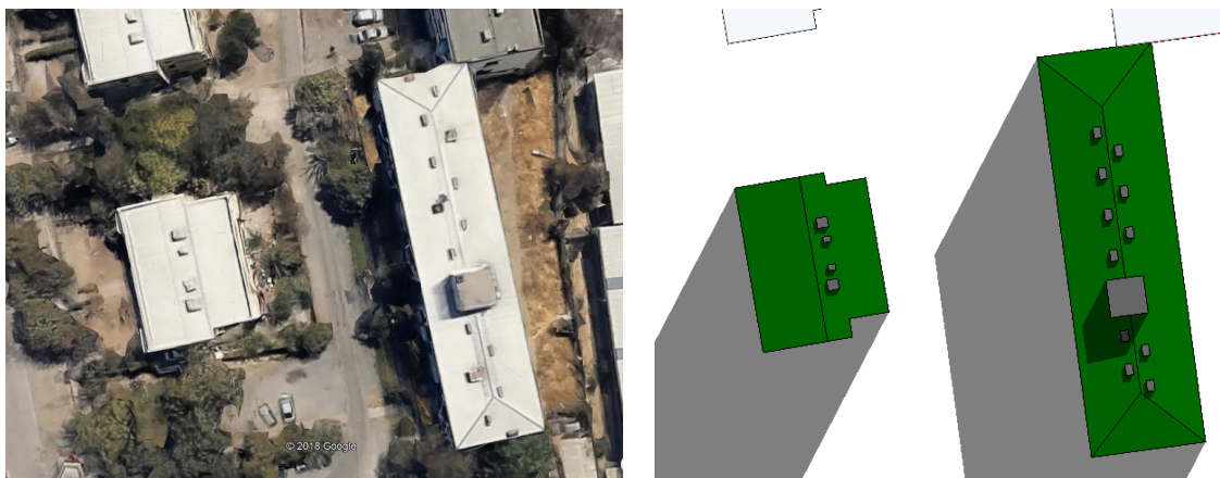
Figura 54. Vista satélite y simulación de los Edificios 3 y 4. (Elaboración propia)
