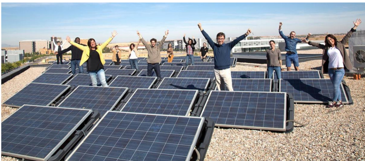
Figura 2. Azotea fotovoltaica de la empresa ECOOO en Madrid (Ecooo, 2018)
