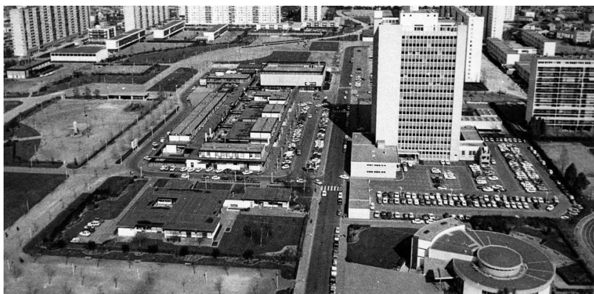
xcviii Grand Parc durante su construcción, 1963. (c) ARCHIVES SUD OUEST
