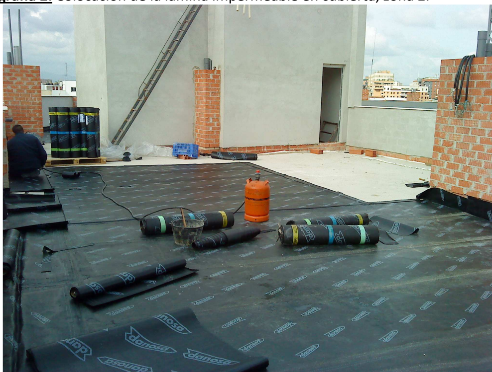
Fotografía 2: Colocación de la lámina impermeable en cubierta, zona 2.
