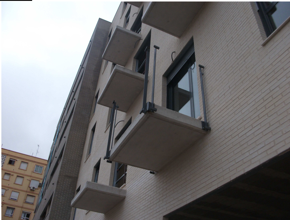
Fotografía 2: Colocación barandillas de voladizos
