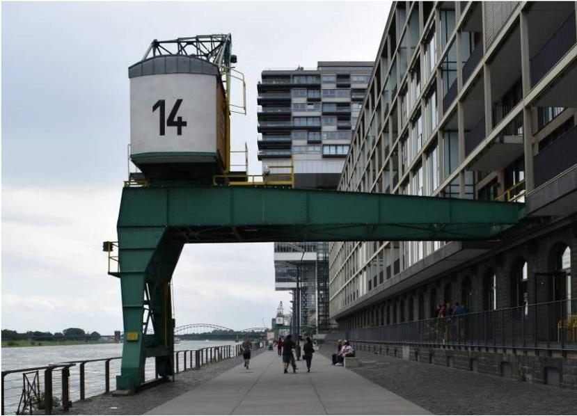
Los edificios se diseñaron con estructuras de acero que simulaban una grúa pórtico. De este modo, una torre de mayores dimensiones y otra de menores dimensiones realizada de cristal, donde se ubican los núcleos de comunicación vertical compuestos por escaleras y ascensores, se conectan por un puente horizontal que vuela.
