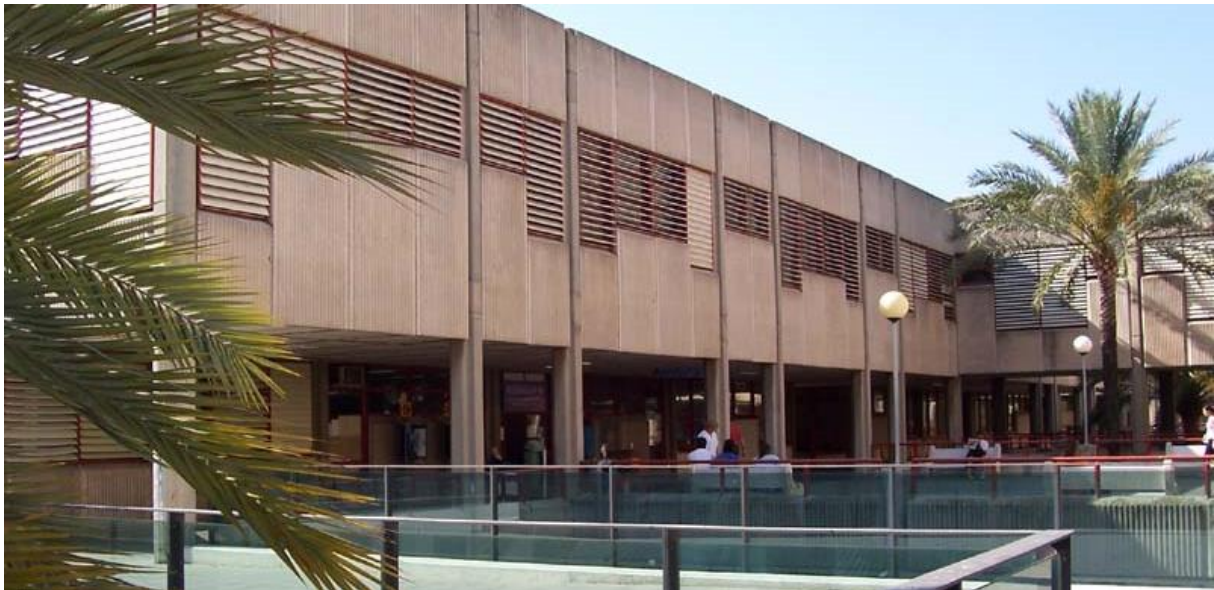
Foto 45. Edificios 4A 4E 4H 4I. Fuente: www.upv.es
