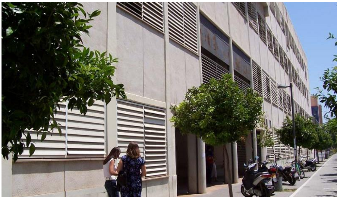
Foto 49. Edificio 4D. www.upv.es
