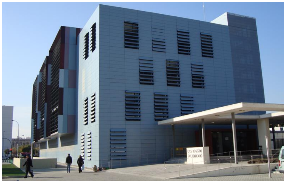
Foto 25. Edificio 1C. Fuente: www.upv.es
