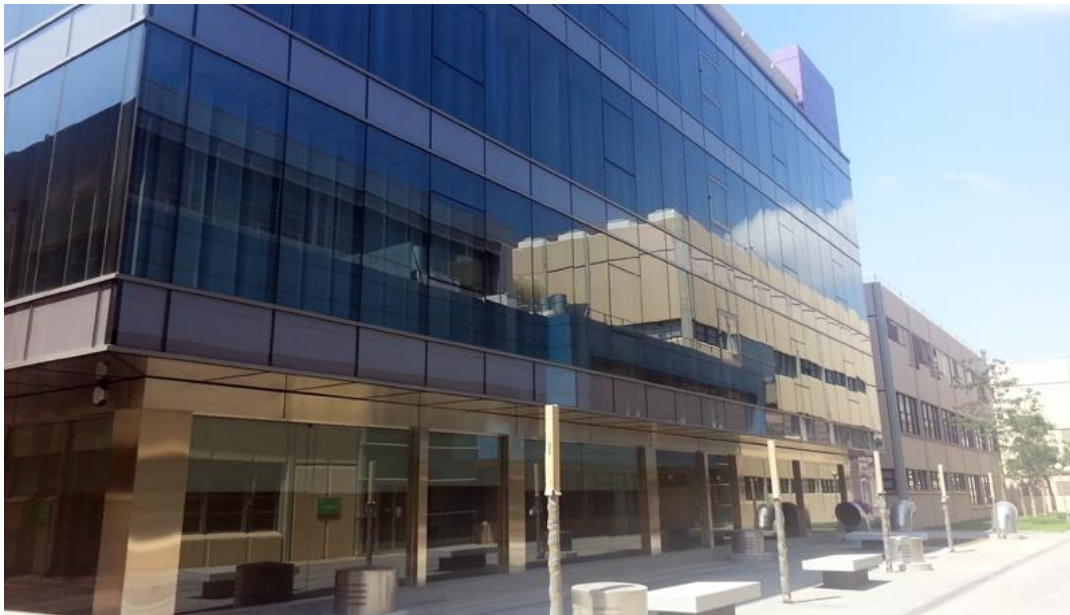
Foto 57. Edificio 4Q. Fuente: www.upv.es
