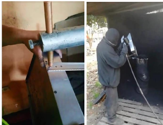
Ilustración 41 Ejemplos riesgo contactos eléctricos directos
