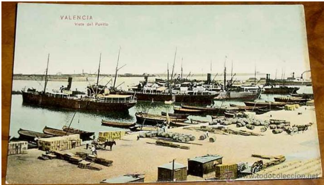
Ilustración 22: Descarga buques mediante barcazas en puerto de Valencia.
