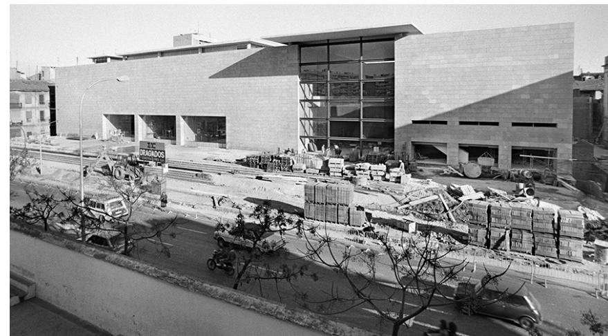
Fig. 3.3. Construcción del edificio del IVAM, 1988 - 1989.
