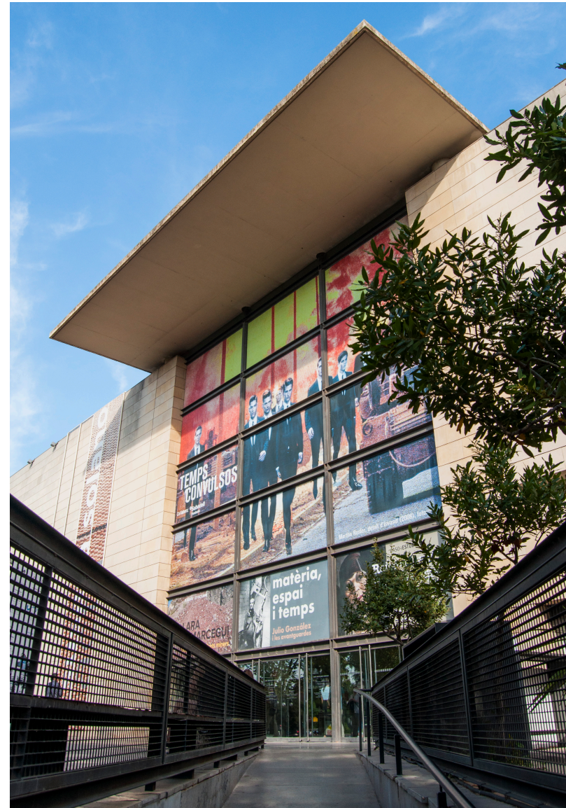
Figura 1.3. Vista de la entrada principal del IVAM, 2019.
