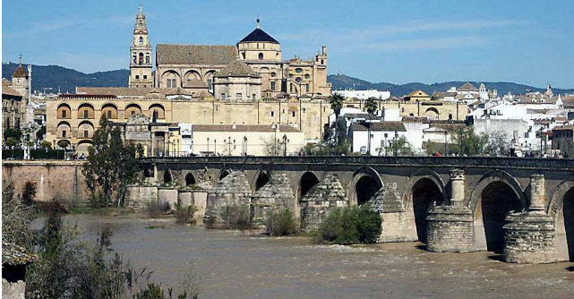
Figura 4. Puente romano de Córdoba
