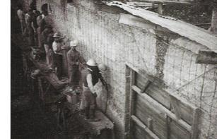
Figura 31. Construcción del muro perimetral.
