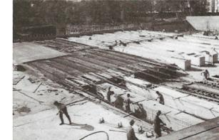
Figura 34. Construcción del forjado del aparcamiento.
