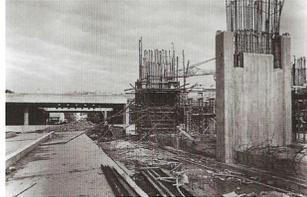
Figura 40. Construcción de los soportes de la Sede.
