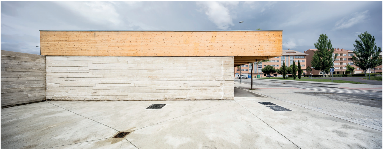
Figure 8. Corner access from parking. 2018. ©MOI / Figura 8. Esquina de acceso desde aparcamiento. 2018. ©MOI.
